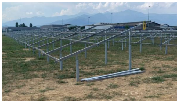
Figura 4.3: Struttura a terra inclinata 20°
