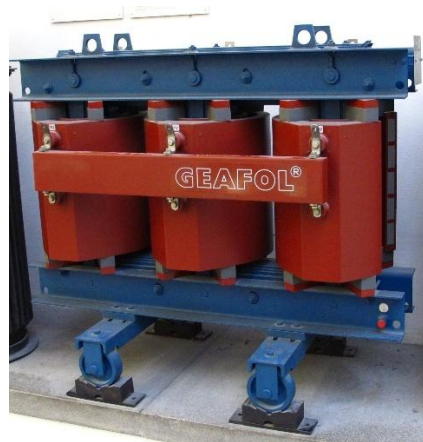
Figura 3.11: Trasformatore a secco in resina 22
