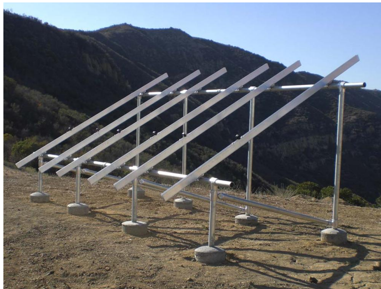
Figura 3.8: Strutture a terra per impianti utility in fase di assemblaggio 17
