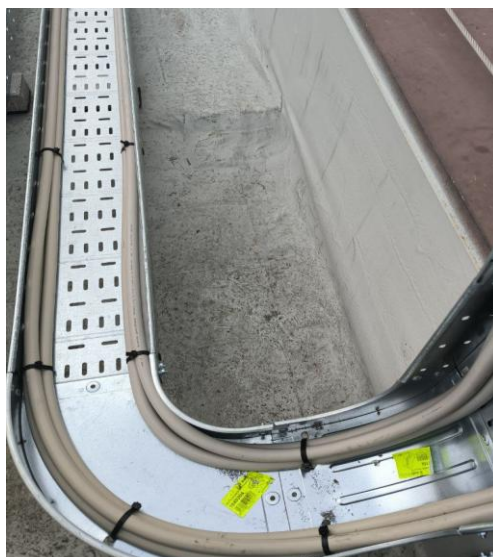
Figura 3.10: Canaline e posa delle terne di cavi in AC
