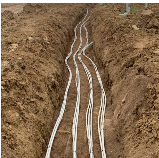
Figura B.4: Scavi per posa dei cavi AC
