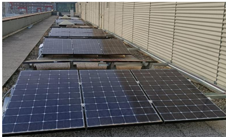
Figura 2.8: Moduli fotovoltaici installati nella terrazza del PVZEN
