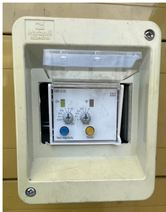
Figura 71: Relè differenziale regolabile.
