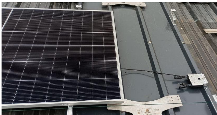
Figura 34: L'ottimizzatore a destra è collegato all'ottimizzatore al di sotto del pannello a sinistra. Foto scattata presso uno degli impianti in realizzazione di Etica nel Sole.
