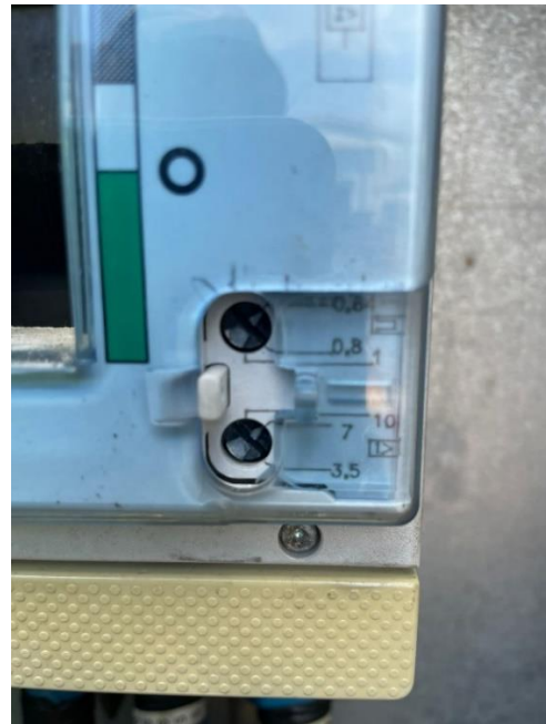
Figura 70: Regolazione della corrente di intervento termico e magnetico del dispositivo generale.
