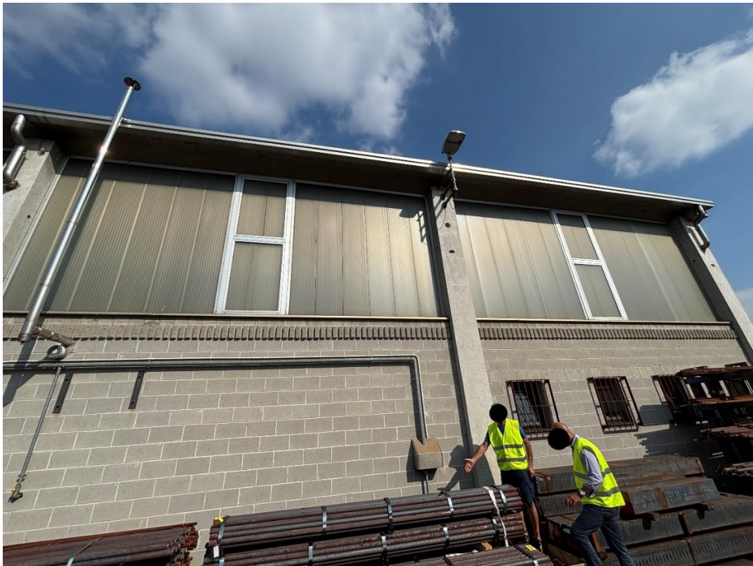
Figura 59: La discesa cavi sarà realizzata lungo il pilastro tra le due finestre.
