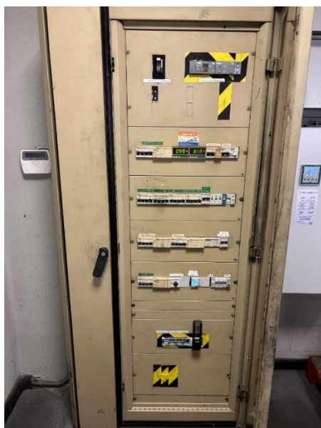
Figura 72: Quadro generale di stabilimento.
