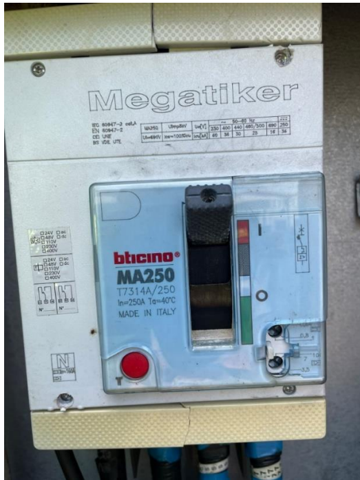
Figura 69: Dispositivo generale.
