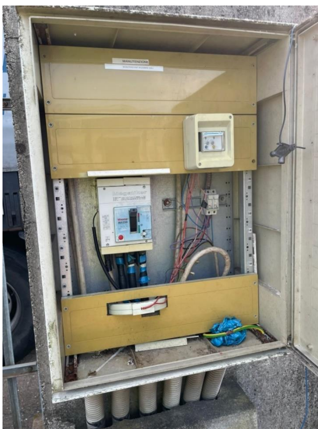
Figura 68: Nicchia contenente il dispositivo generale e il relè differenziale regolabile
