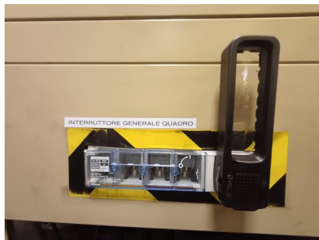
Figura 73: Sezionatore del quadro generale di stabilimento.
