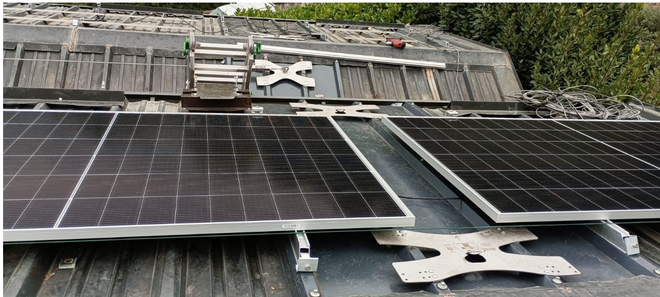
Figura 65: Esempio di cavo passante trasversalmente alla linea vita di un impianto realizzato da Etica nel Sole. Foto scattata presso uno degli impianti in realizzazione di Etica nel Sole.
