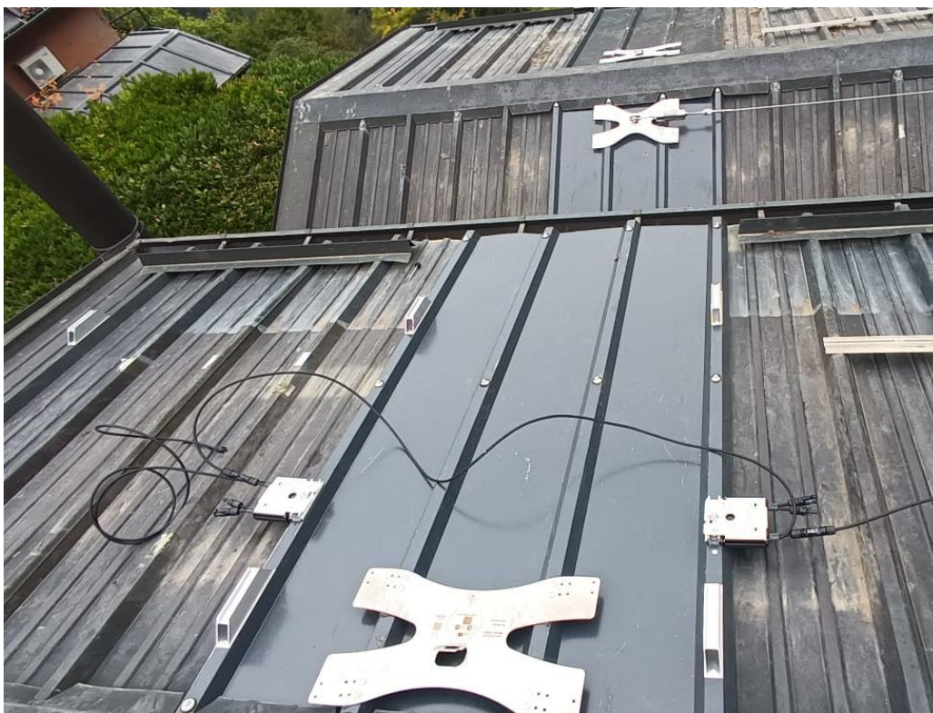
Figura 33: Ottimizzatori fissati sulle guide e collegati tra loro. Foto scattata presso uno degli impianti in realizzazione di Etica nel Sole.
