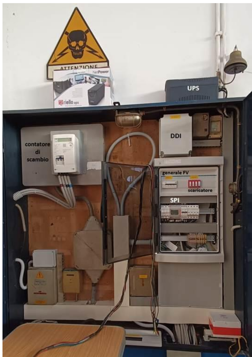
Figura 46: Quadro fotovoltaico.
