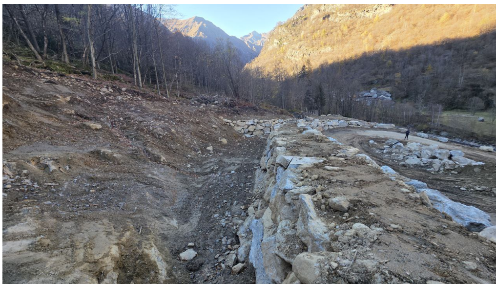
Figura 133: Foto del canale zona masso ciclopico
