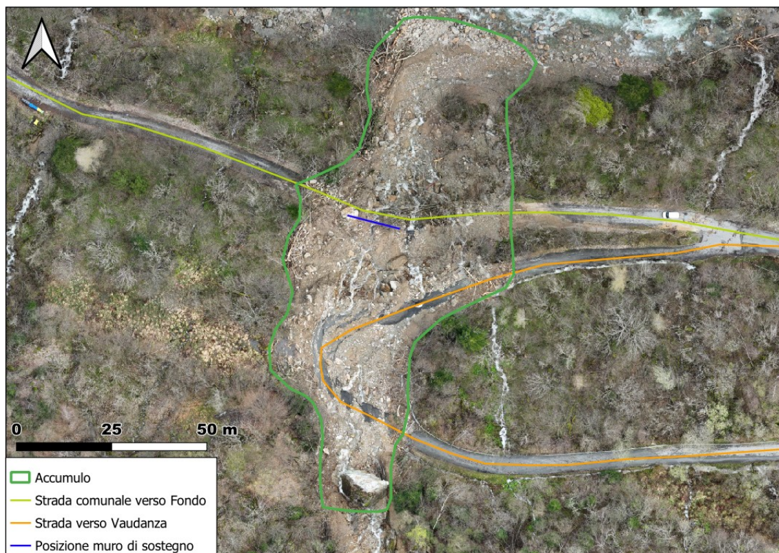
Figura 61: Zona di accumulo del debris flow
