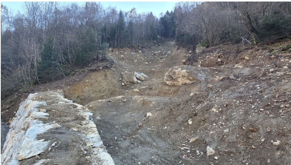
Figura 139: Zona del masso ciclopico dopo i lavori
