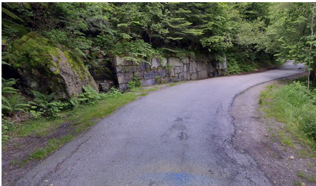
Figura 63: Muro di sostegno e scarico di acqua
