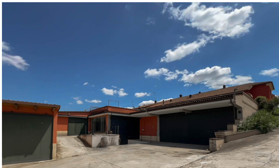
3.4 / Cortile area produttiva, foto dell'autore
