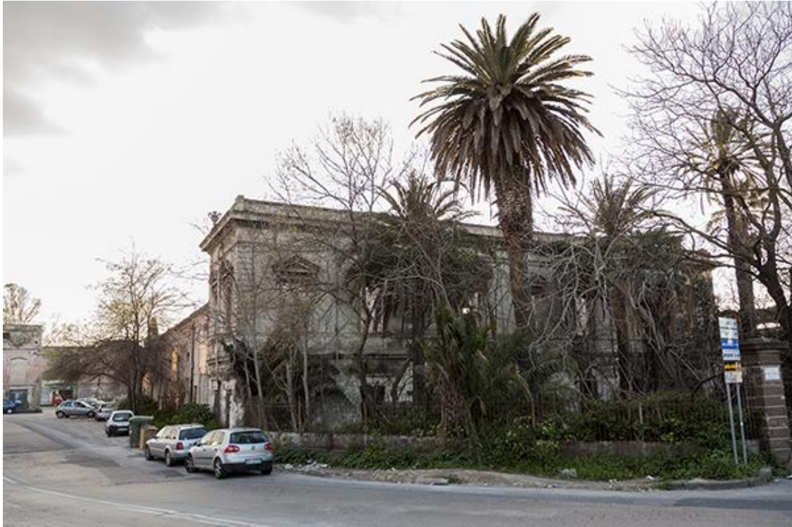
Fotografia dello stato attuale dell'edificio dopo l'incendio
