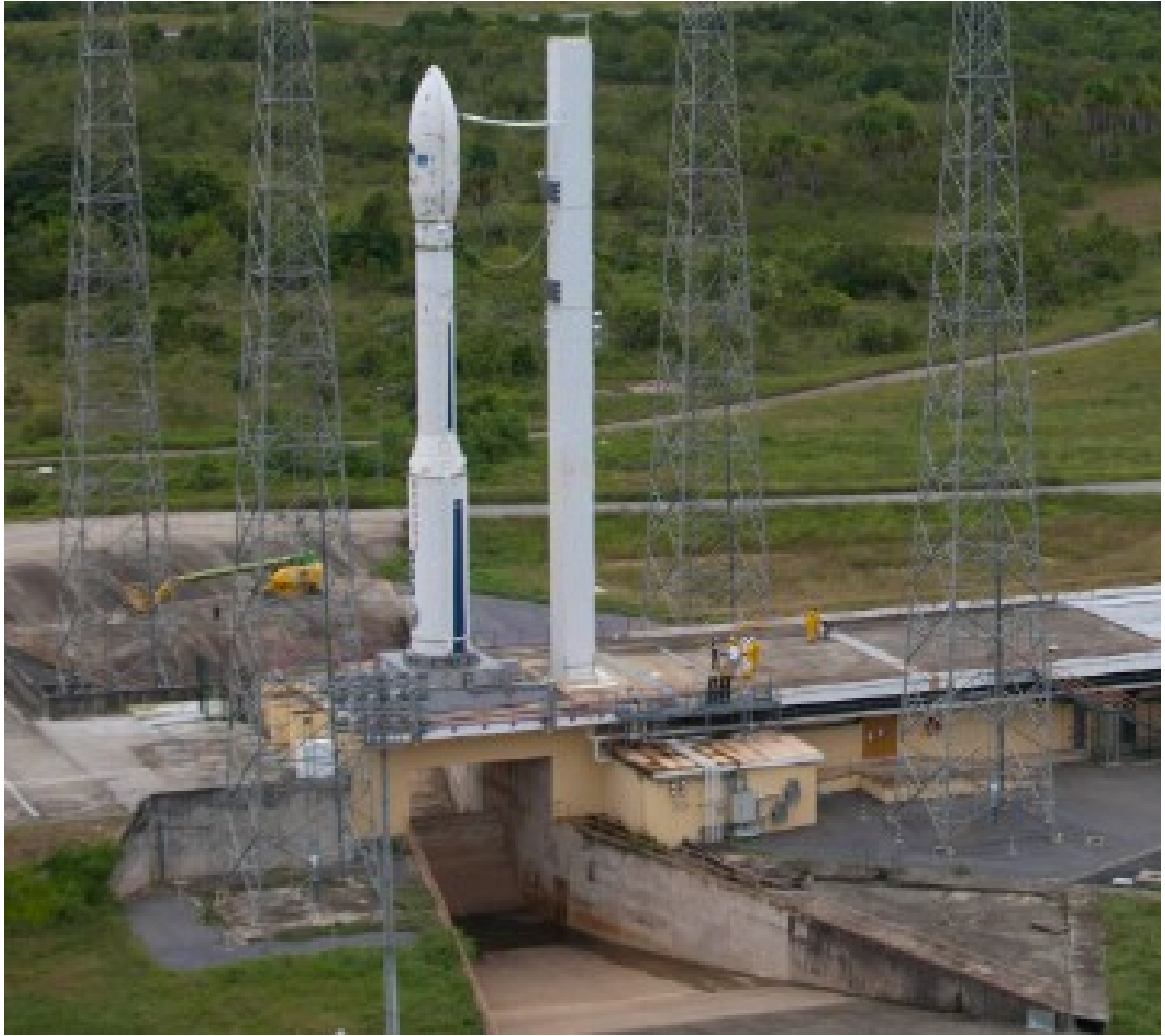
Figura 16: VEGA posizionato sulla rampa di lancio (si possono notare i condotti di scarico citati precedentemente) da [5c]
