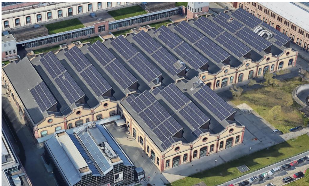
Figura 4-1: Impianto Cittadella del Politecnico di Torino
