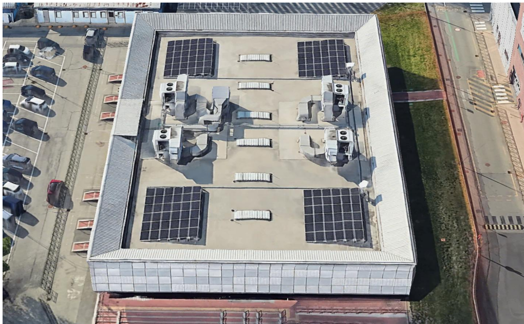
Figura 4-3: Impianto Aule P del Politecnico di Torino
