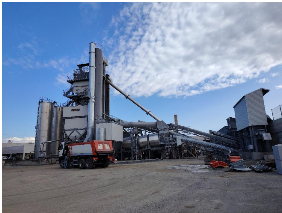
Figura 40. Miscelatore in impianto
