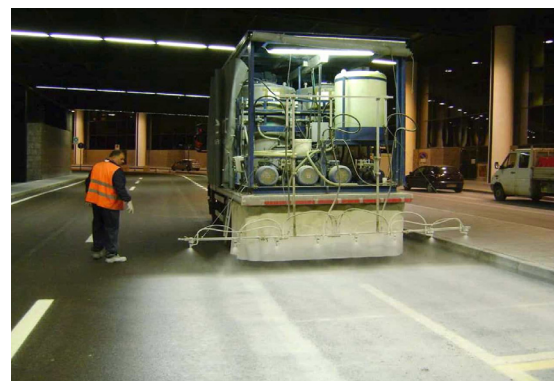
Figura 108 - Applicazione trattamento antismog a Milano Malpensa
