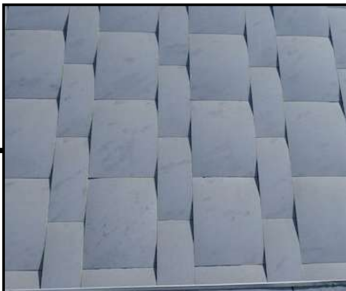
Lastre piegate della Finlandia Hall di Alvar Alto
