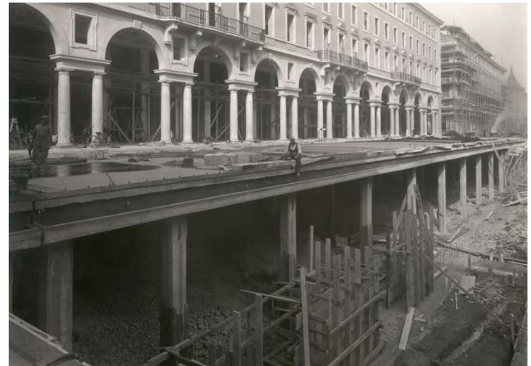
[Fig. 50] Rifacimento di via Roma a Torino e realizzazione del tunnel tranviario, data ed autore sconosciuti.
