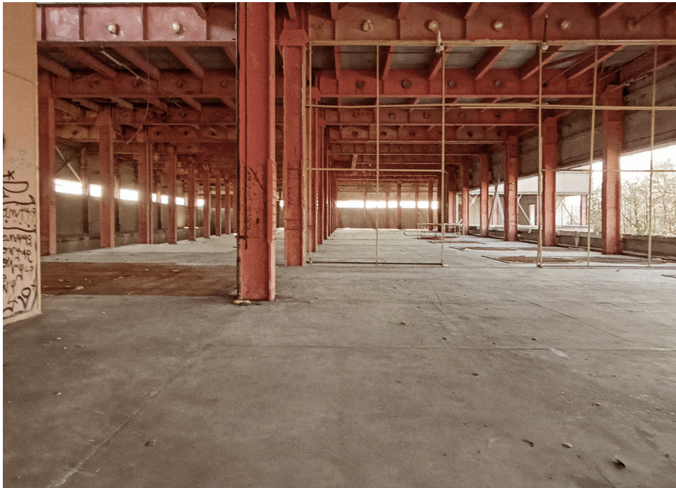
↑ Struttura dei vecchi tramezzi divisori interni. Fotografia del primo piano
