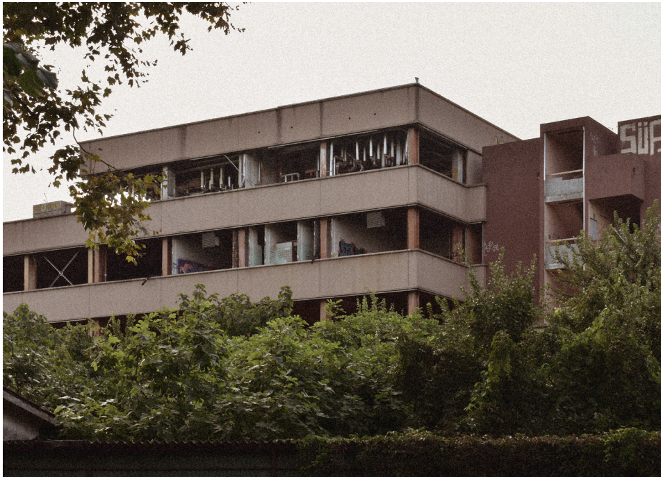
↑ Impianti a vista da corso Regio Parco
