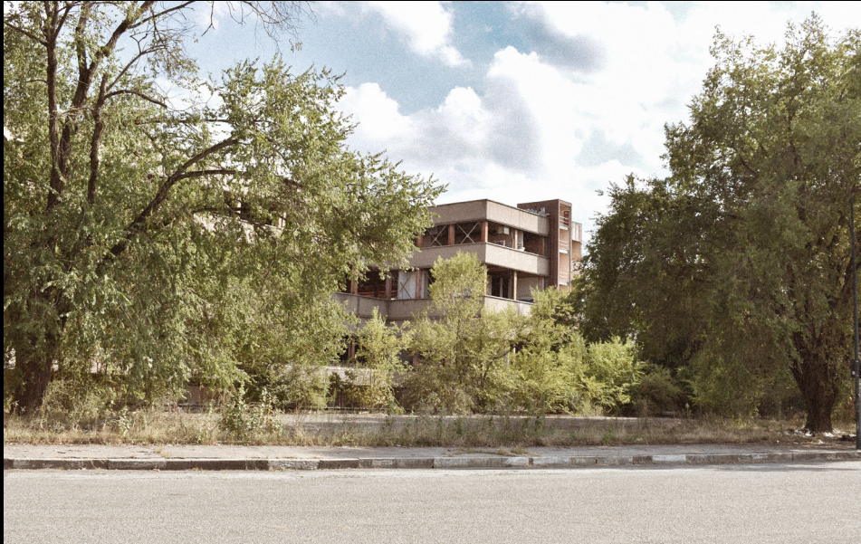
← Scorcio dell'edificio tra la vegetazione da corso Regio Parco ↑ Scorcio dell'edificio tra la vegetazione da via Monteverdi
