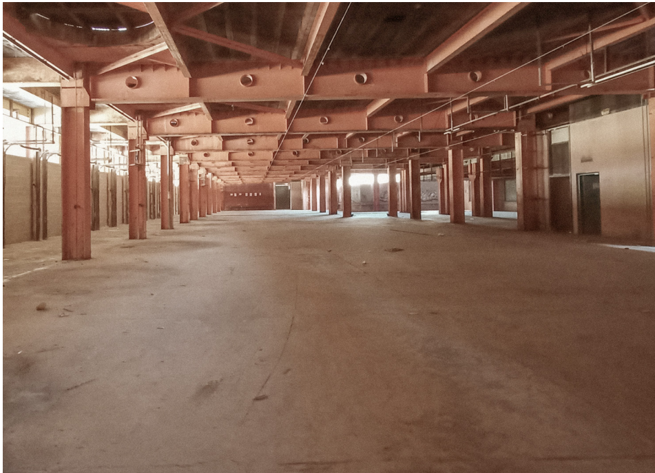
↑ → Struttura in acciaio con travi e pilastri verniciati e lasciati a vista. Fotografie del piano terra
