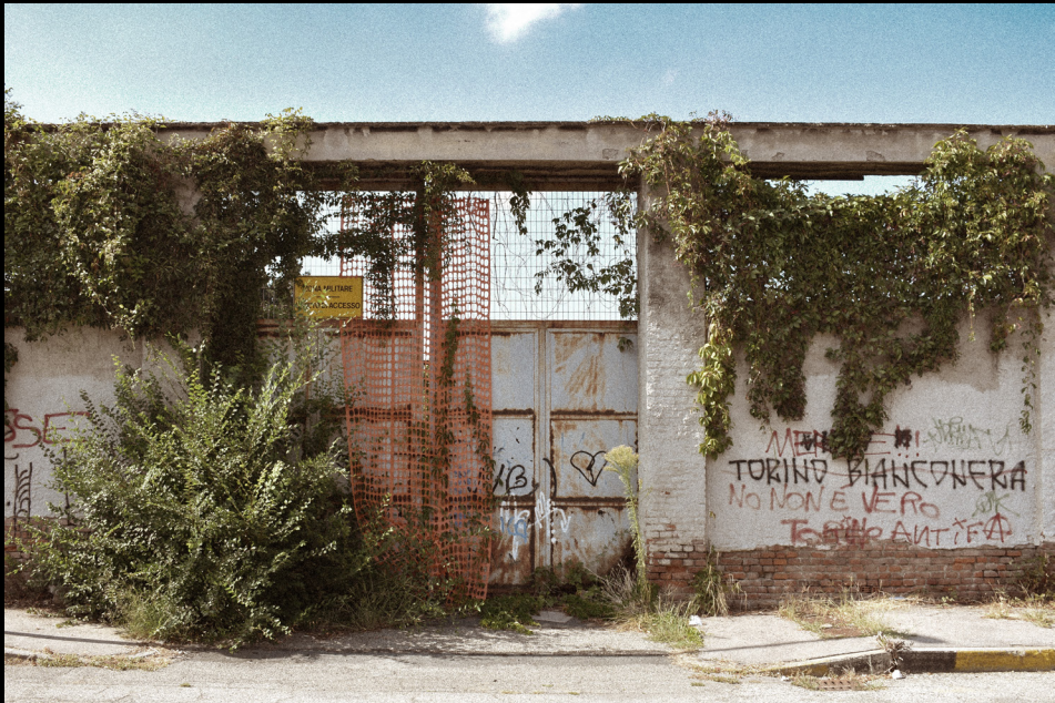
↑ Muro perimetrale delle fabbriche su via Monteverdi e via Cimarosa
