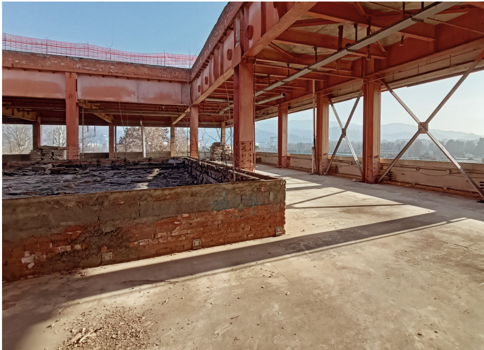
↑ Terrazzo panoramica con controventi a vista. Fotografia del terzo piano
