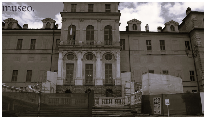
venerdì 9 maggio 2025_ Restauro conservativo dello scalone
