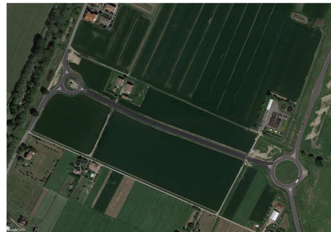
[Figura 1.7] Completamento della variante SP27, Valle del Samoggia 26 aprile 2019.
