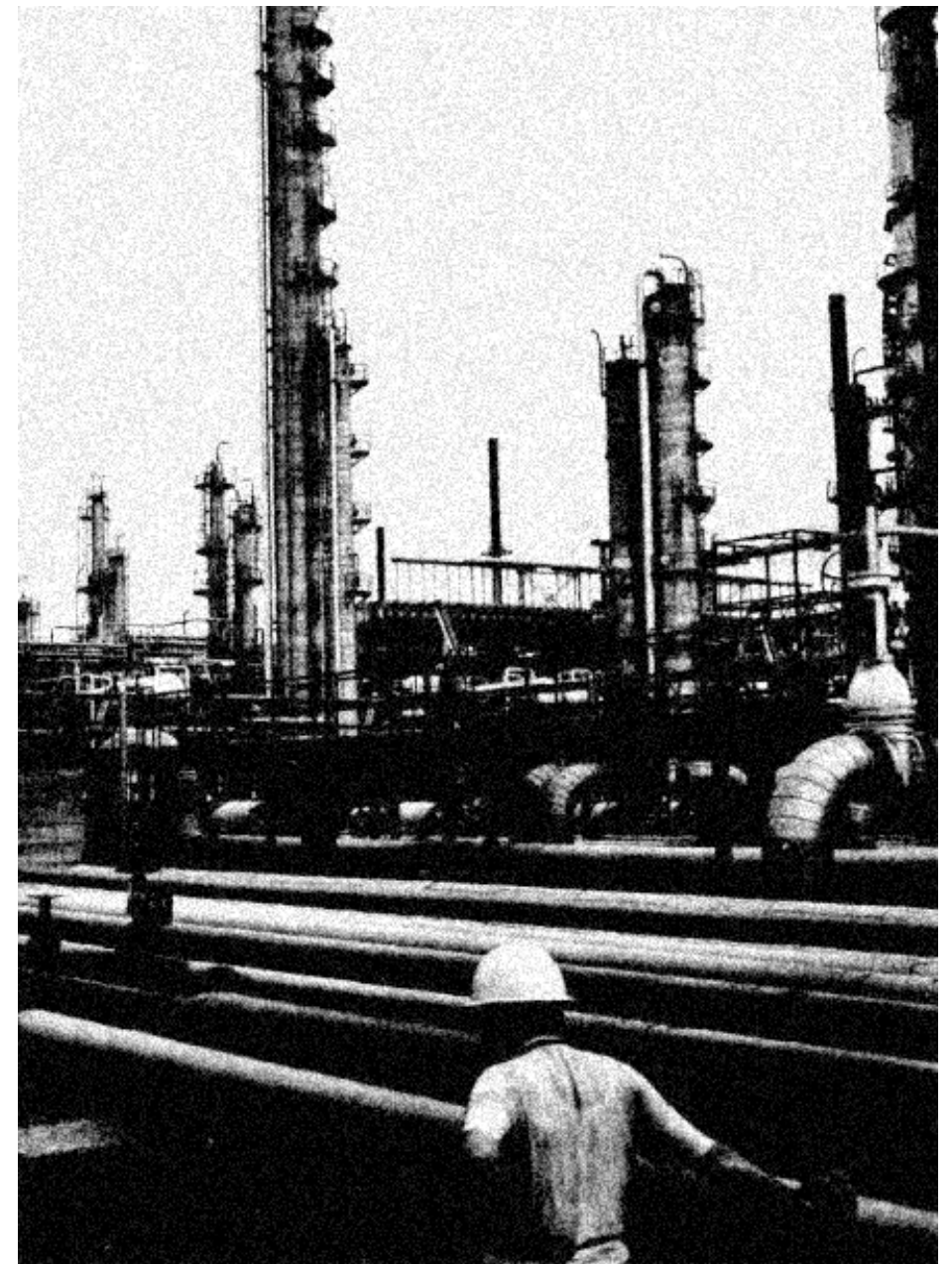
Raffineria di Sarroch, alla periferia di Cagliari
