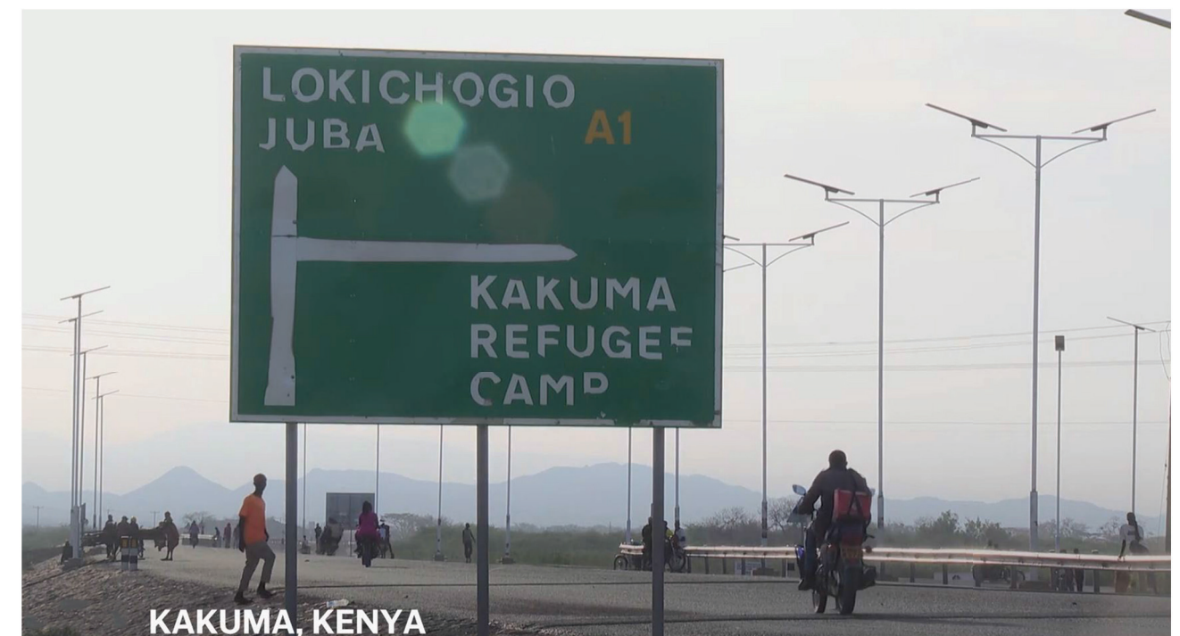
Fig. 36 – Vista strada di accesso per il campo profughi di Kakuma, Kenya (15 febbraio 2025). AP Photo/Jackson Njehia.
