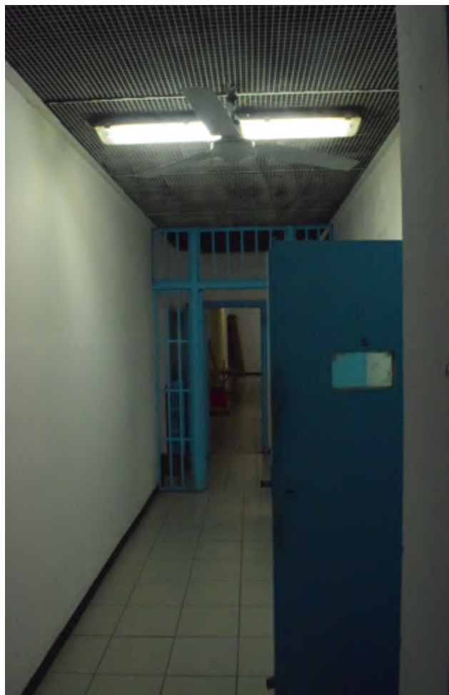
Corridoi perimetrali dei sopralluoghi
