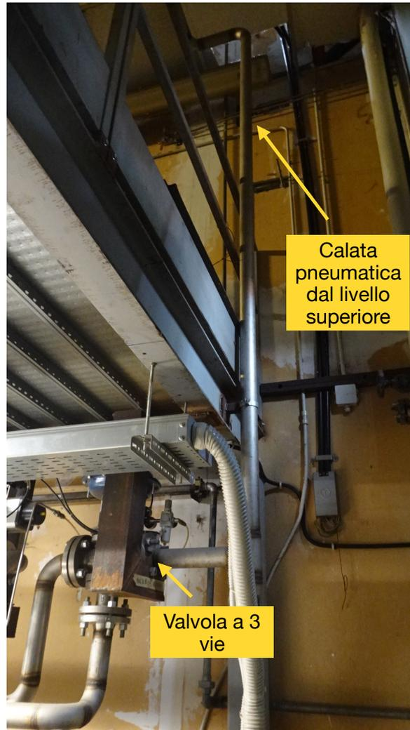
Figura 2.6: Particolare della calata pneumatica.
