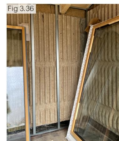
Figura 3.36 - Vista generale interna con montanti in acciaio e infissi (Fonte: Fotografia dell'autore)
