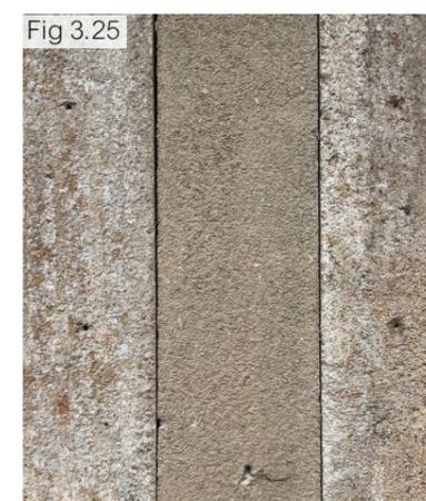
Figura 3.25 - Cassero a perdere del pilastro (Fonte: Fotografia dell'autore)
