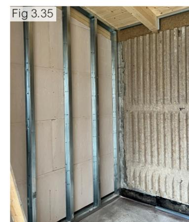
Figura 3.35 - Parete di tamponamento interna (Fonte: Fotografia dell'autore)
