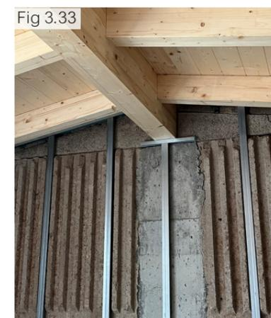
Figura 3.33 - Disposizione montanti in acciaio su parete (Fonte: Fotografia dell'autore)
