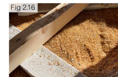
Figura 2.16 - Lolla di riso sfusa per massetto a secco
