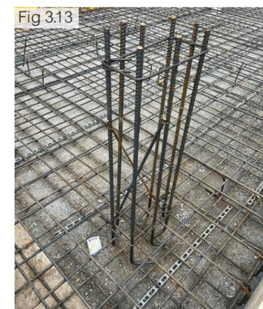
Figura 3.13 - Armatura del pilastro in calcestruzzo (fonte: Credits Rice House)
