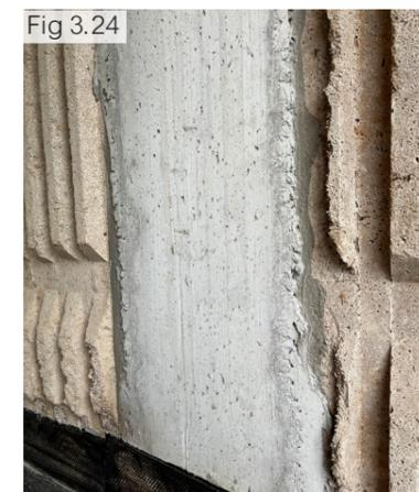
Figura 3.24 - Confronto parete interna RCW e pilastro in calcestruzzo armato (Fonte: Fotografia dell'autore)
