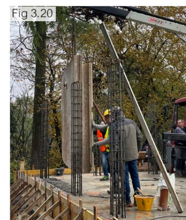
Figura 3.20 - Appoggio parete RCW con malta di allettamento (fonte: foto dell'autore)
