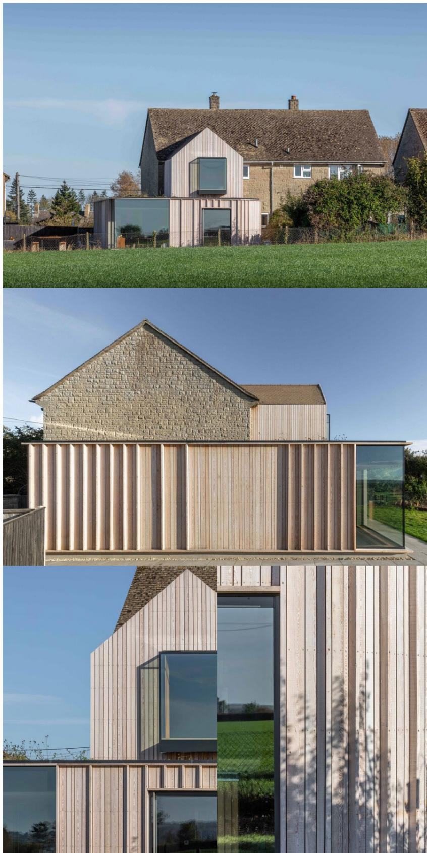
Figura 33 – Corner View House. Dettaglio del rivestimento di facciata in legno di larice. Fonte: <https://www.freehausdesign.com/corner-view-house>. Diritti fotografici: Nicholas Worley
