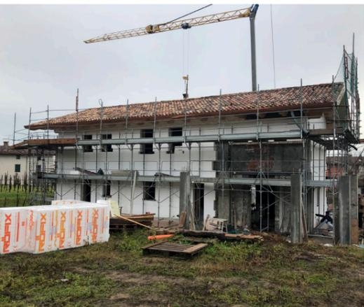
Le murature perimetrali originali in pietra "a sacco" sono state mantenute e valorizzate. Per il miglioramento delle prestazioni energetiche, si è intervenuti con l'applicazione di un cappotto esterno in EPS, rifinito con rasatura, che garantisce uniformità e protezione all'isolamento (Fig. 62).
