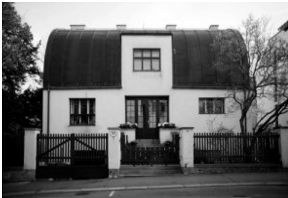
▲ Fig. 6-7 Villa Steiner (1910): la copertura scelta costituisce uno stratagemma per rendere il sottotetto abitabile, forzando così il regolamento edilizio, che stabiliva che sul prospetto principale su strada i piani non potessero essere più di due. Loos interpreta in chiave moderna il tetto rustico e ripropone un modello tipologico tradizionale, in risposta a precise esigenze piuttosto che per una scelta di stile. A sinistra: Prospetto principale. A destra: pianta piano terra. Fonte: https://ita.archinform.net
