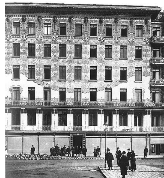
▲ Fig. 3 Foto del prospetto principale sulla strada. Fonte: https://www.archdaily.com/ .
