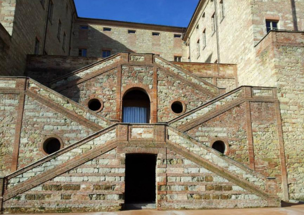
Facciata principale Palazzo Callori.
