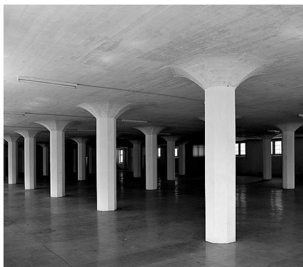
**Figura 2.** Pilastri a fungo, granaio di Altdorf.
