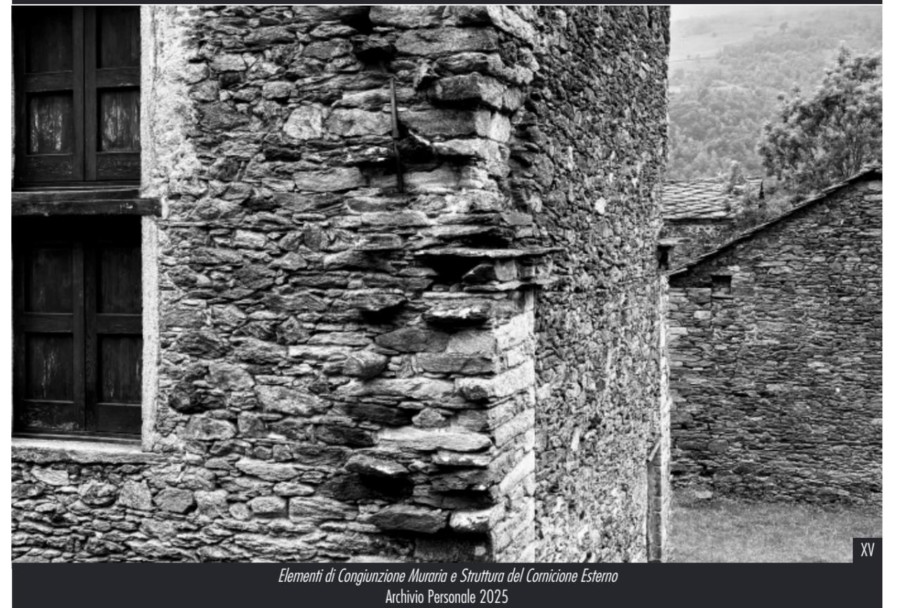
Elementi di Congiunzione Muraria e Struttura del Cornicione Esterno
