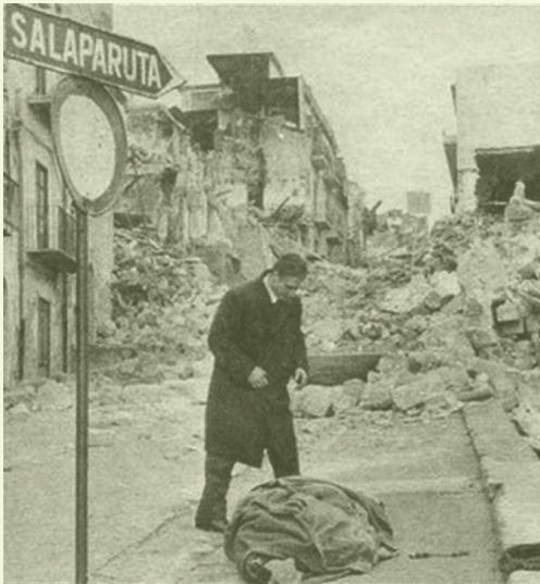
Salaparuta: crolli e distruzioni all'entrata del paese
