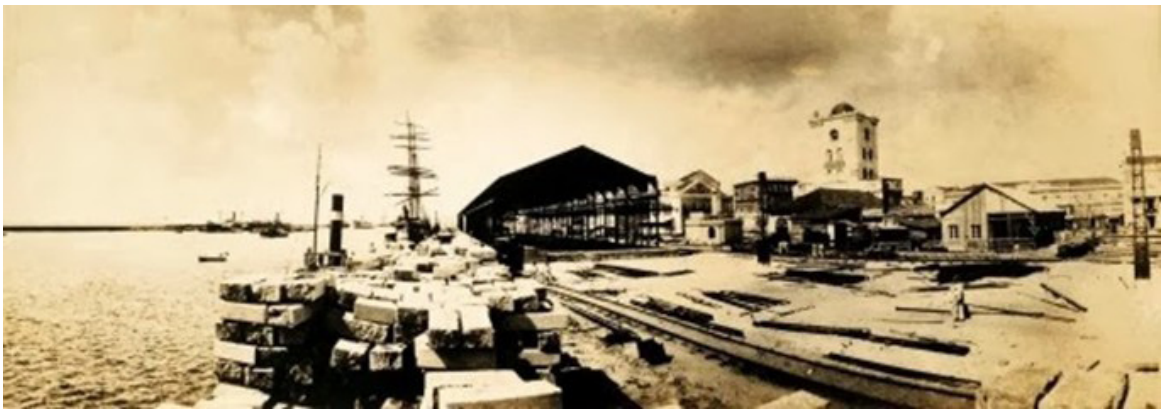
(Fig. 3) Costruzione del porto di Recife, 1913
