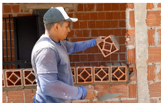
(Fig. 86) Metodo di posa dei cobogó in terracotta.
