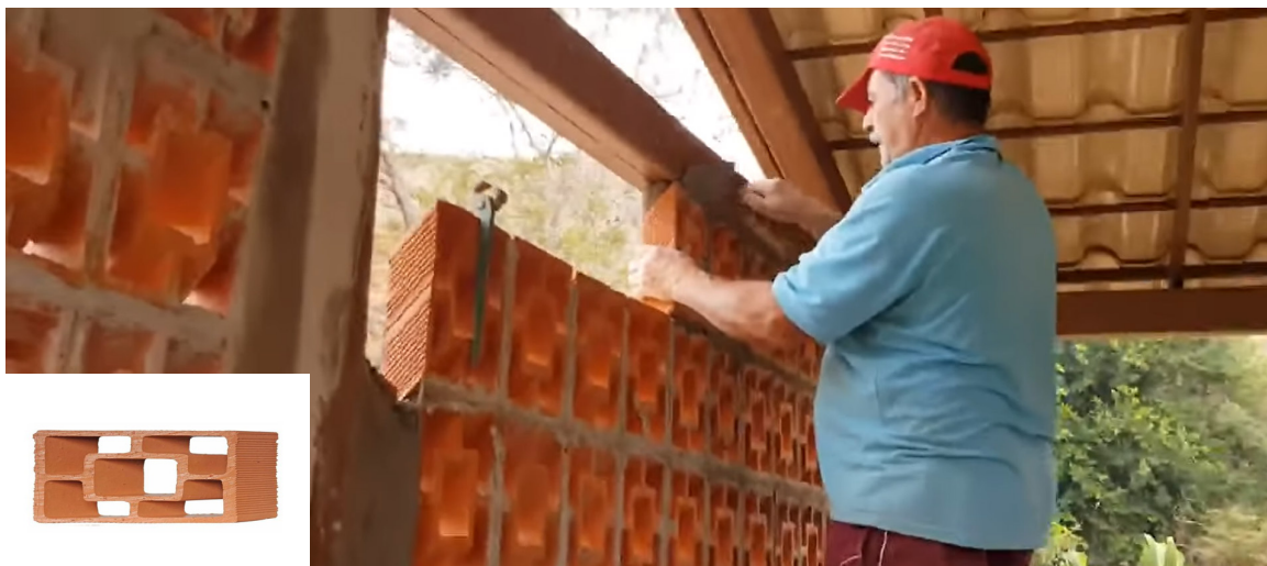
(Fig. 85) Applicazione di un cobogó diagonal in un'abitazione rurale esposta a frequenti precipitazioni.
