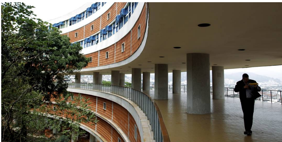
(Fig. 36) Facciata del Conjunto Residencial Prefeito Mendes de Moraes
