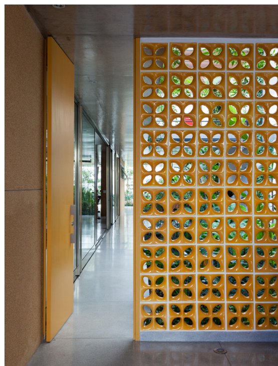
(Fig. 67, 68 e 69) Esempi contemporanei dell'uso del cobogó come elemento divisorio tra ambienti.
