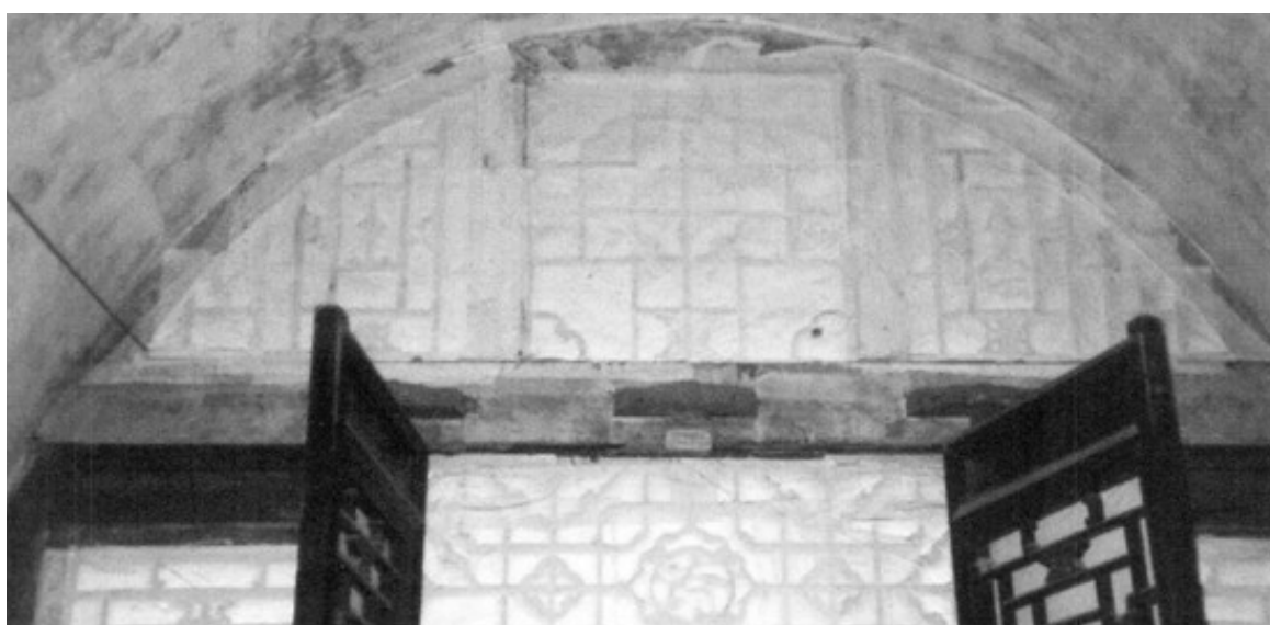
(Fig. 9 e 10) Vista esterna e interna della facciata arcuata a grata del jian centrale di uno zhengfang , 1996
