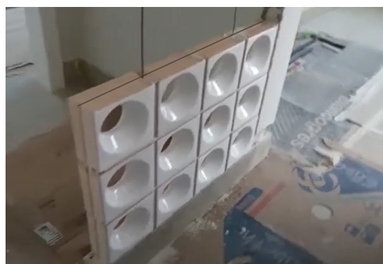
(Fig. 100) Posa del cobogó in ceramica smaltata con l'ausilio di aste in alluminio.
