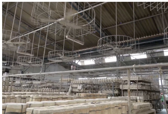
(Fig. 97) Ambienti dotati di ventilatori a soffitto per l'asciugatura dei pezzi.
