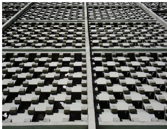
(Fig. 41) Facciata dell' Edifício Santo Antônio
