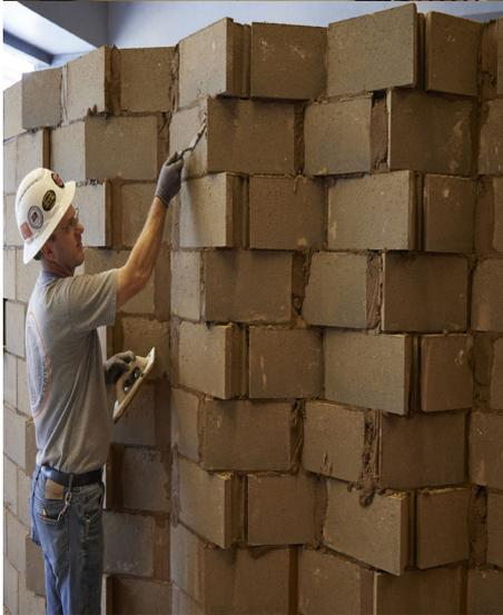
Il Bio-Block è un mattone realizzato a partire da microalghe. Questo progetto è stato presentato alla Biennale di Architettura di Chicago nel 2023. Vengono utilizzate le microalghe come componente principale all'interno di una matrice di materiali che formano il biopolimero, esse sono note per la loro capacità di **catturare anidride carbonica** dall'atmosfera.
