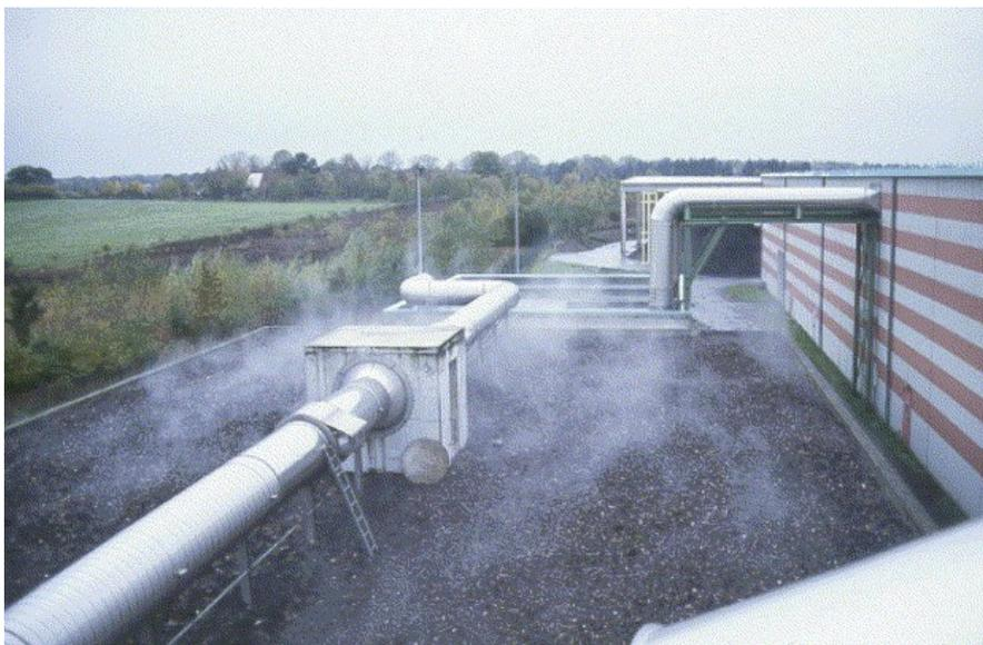
**Figura 4.7** Foto di uno dei biofiltri dell'impianto di compostaggio situato in Germania (impianto B) (Schlegelmilch et al., 2005a)
