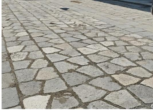
*Figura 41 Particolare pavimentazione masselli a cinque facce via Cesare Lombroso, Torino*
