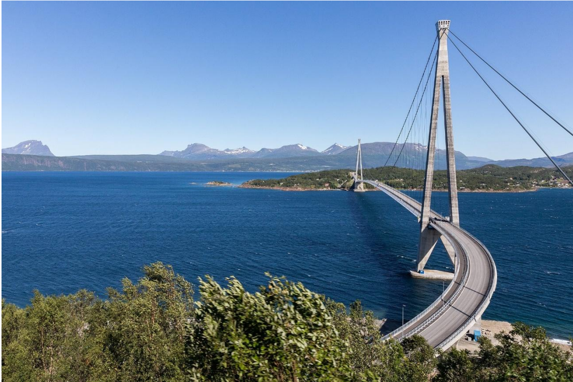
Figura 12 Ponte di Hålogaland - Markus Trienke - Nordnorwegen, CC BY-SA 2.0.
