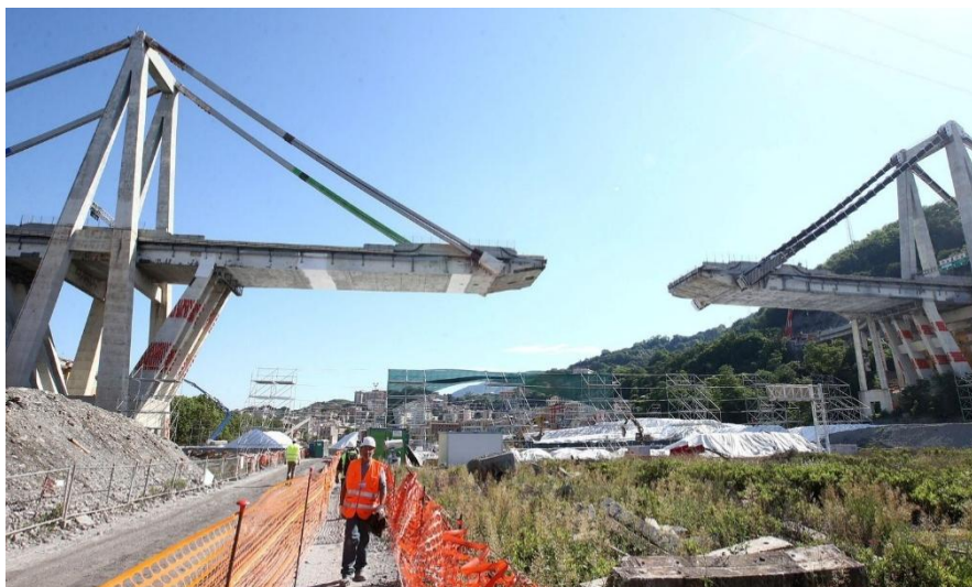
Figura 1 Ponte Morandi – Agf
