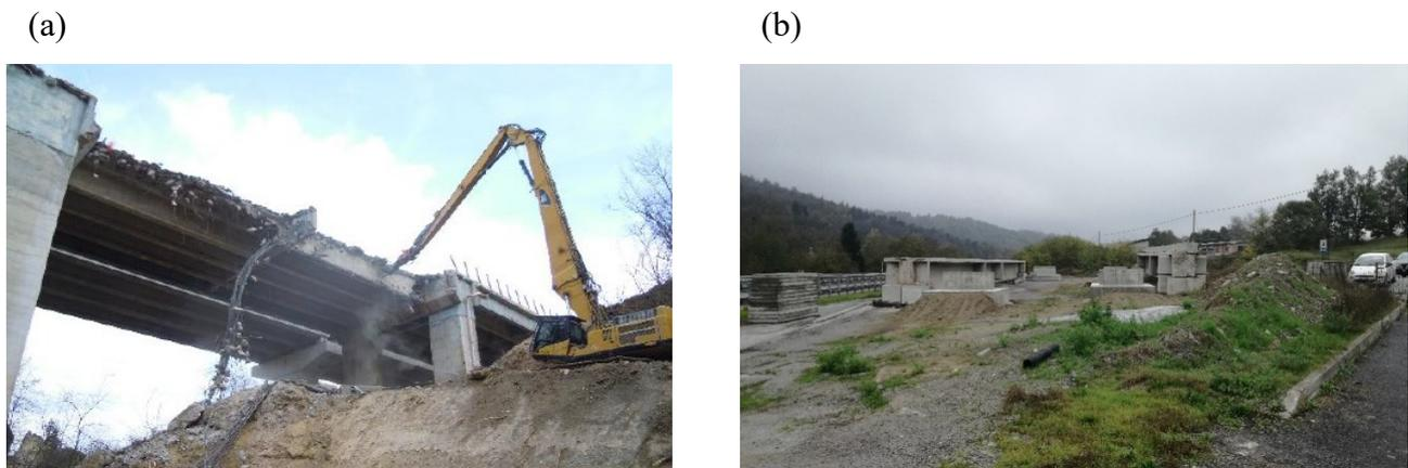
**Figura 2-1.** a) Dismissione dell'impalcato. b) Campo prove con travi posizionate. Tratte dal "Report Finale Prove di carico sulle travi in C.A.P. di luce 34.60 m ed in C.A. di luce 25.90 m. AUTOSTRADA A6 TORINO-SAVONA"<sup>[17]</sup>.
