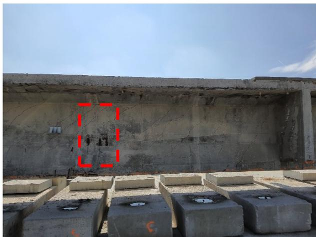
**Figura 2-10.** Corrosione delle staffe d'anima in corrispondenza dei fori per lo smaltimento delle acque, da documentazione fotografica della prova.
