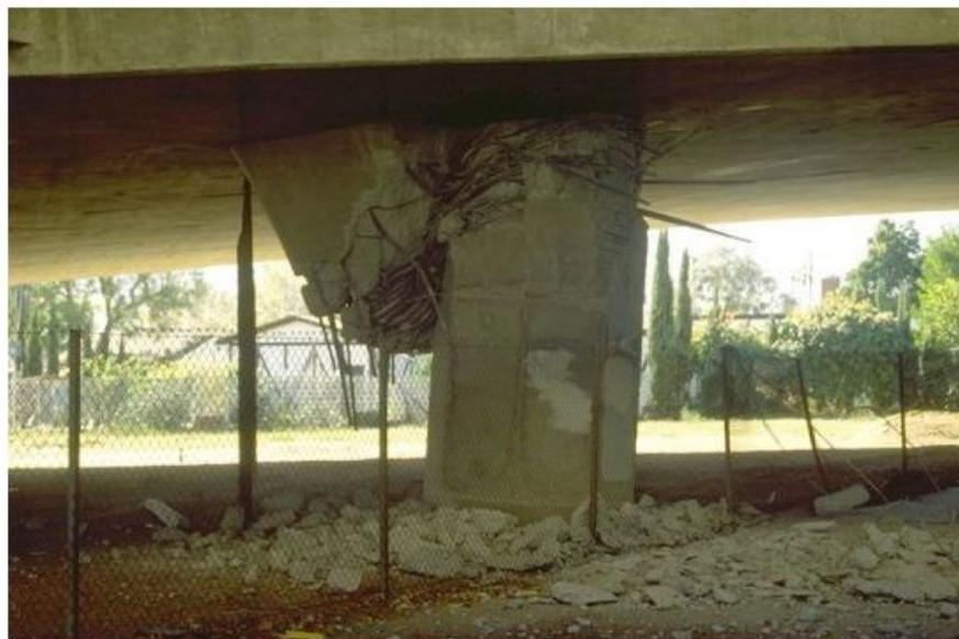
*Figura 31 – Collasso a taglio nella regione della cerniera plastica, Terremoto di Northridge, California, 1994.*
