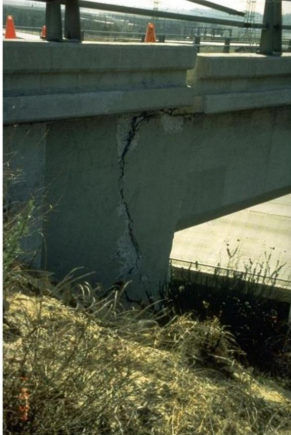
*Figura 32 - Danneggiamento spalla, Terremoto di Northridge, California, 1994.*
