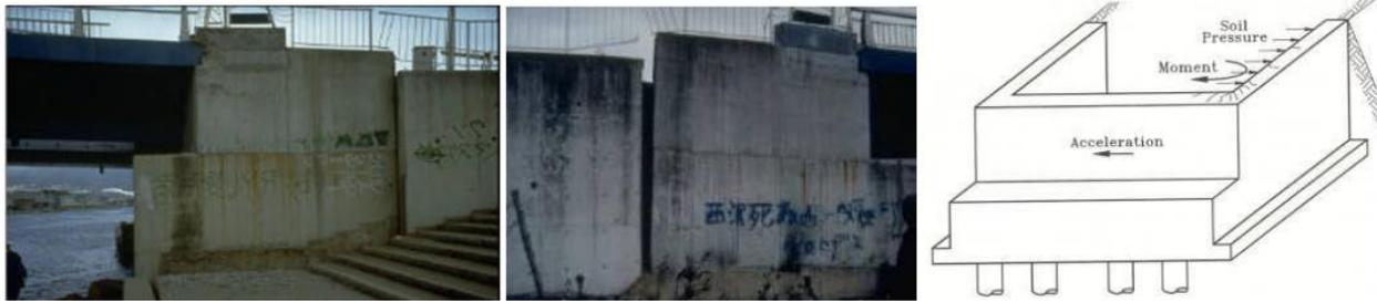
Figura 35 - Cedimenti relativi spalla-rilevato.
