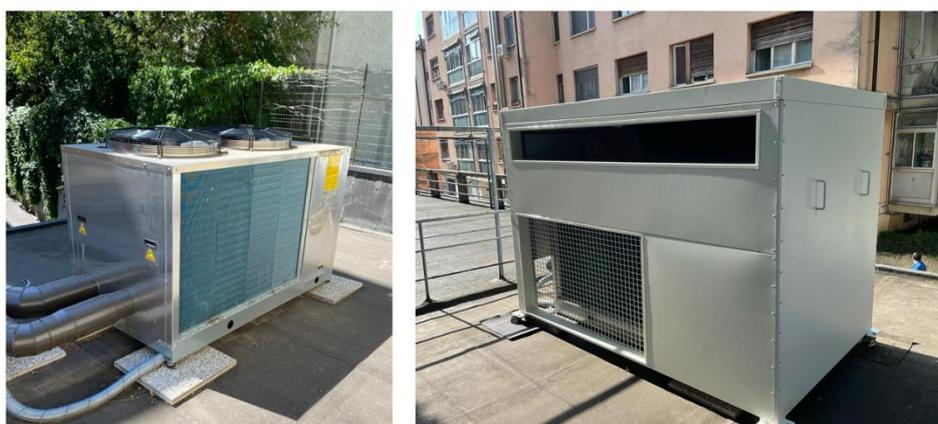
*Figura 4.14 - Pompa di calore esterna con barriera acustica (a destra).*
