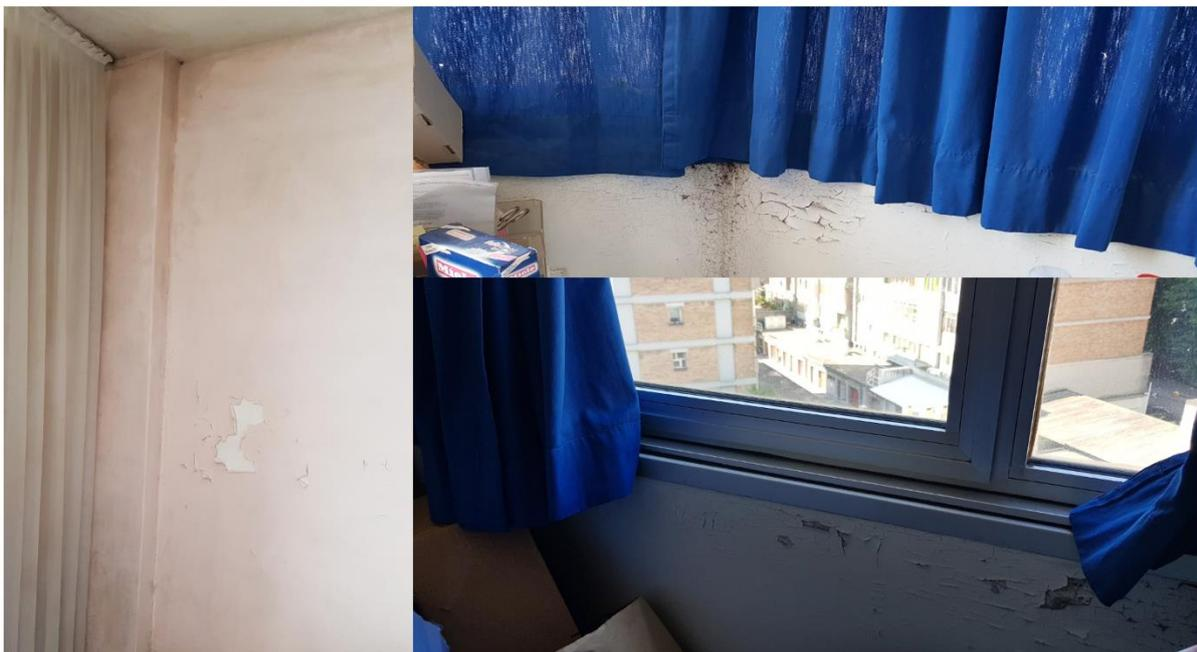
**Figura 4.2** - Formazione di muffa e condensa interna dovuta ai ponti termici nello stato pre-retrofit.
