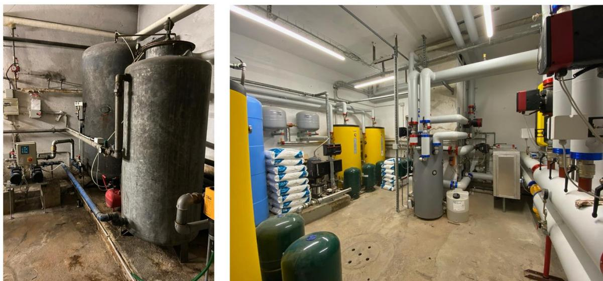
*Figura 4.8 - La centrale termica nello stato antecedente agli interventi è visibile a sinistra, mentre a destra è riportata la configurazione successiva alla riqualificazione.*
