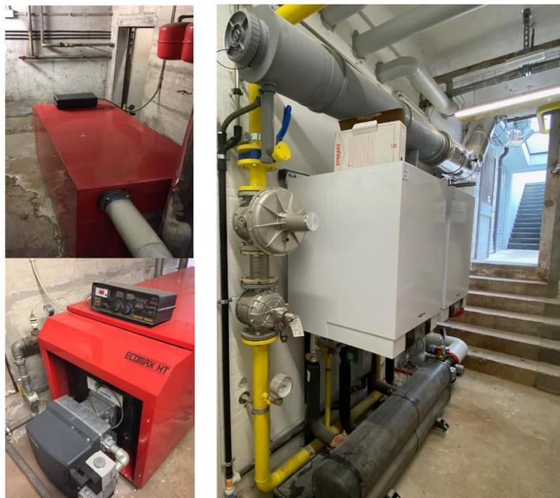
**Figura 4.7** - A sinistra sono visibili due immagini della caldaia tradizionale pre-retrofit, a destra sono presenti le due caldaie modulari a condensazione installate dopo la riqualificazione.
