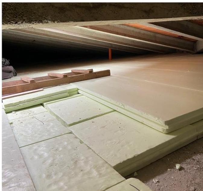
**Figura 4.12** - Posa della doppia pannellatura in XPS nel sottotetto.
