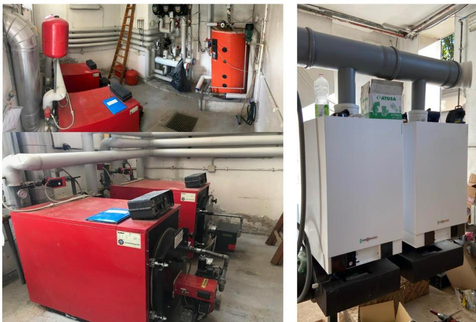
*Figura 4.13 - Centrale termica: confronto tra stato pre (a sinistra) e post riqualificazione (a destra).*
