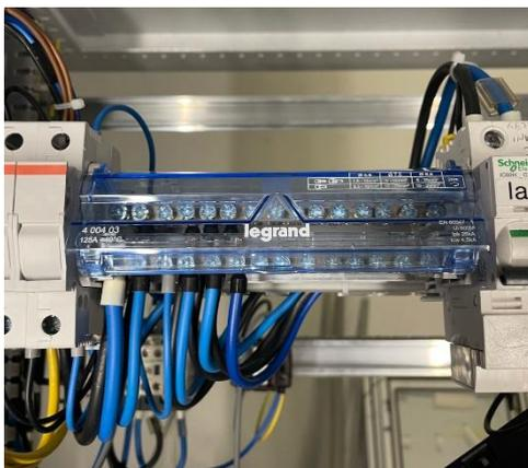
*Figura 3-19: particolare morsettiere LeGrand installata*
