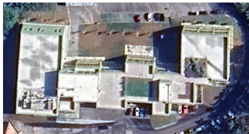
Figura 4.1. Tetto dell'IIS C. Denina sede ITIS Rivoira (Foto scattata il 24/09/2023 da Google Earth) [27]
