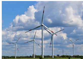
Figura 1.19. Aerogeneratore eolico ad asse orizzontale [3].
