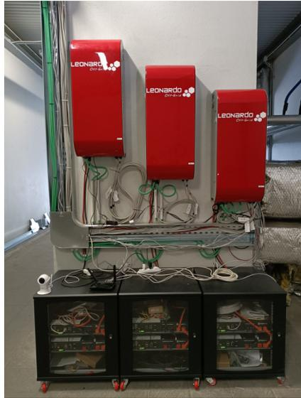
Figura 2.4: Vista frontale dei tre inverter trifase Leonardo PRO X 8000/48 Off-Grid installati in parallelo. Nella parte inferiore sono visibili i sistemi di accumulo ai quali gli inverter sono collegati.
