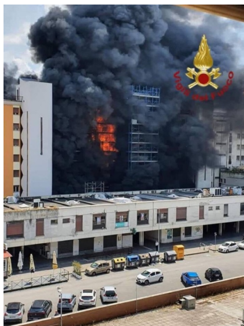
Figura 45. Incendio in fase di avanzata propagazione [55]
