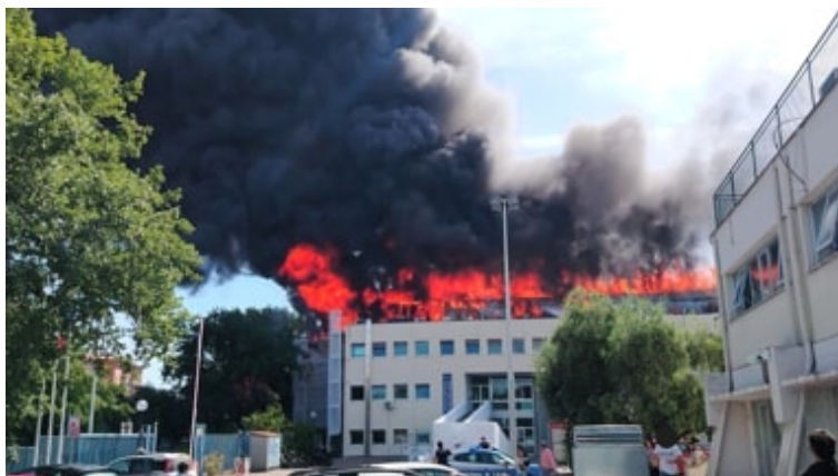
Figura 60. Incendio copertura Unitus [81]
