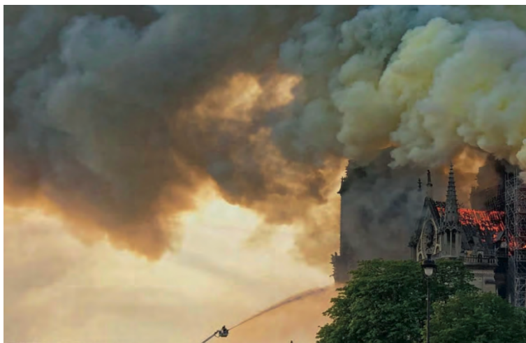
Figura 28. Incendio Notre Dame [5]
