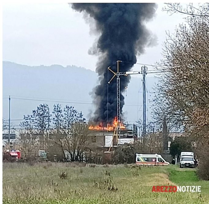
Figura 35. Incendio in copertura [36]
