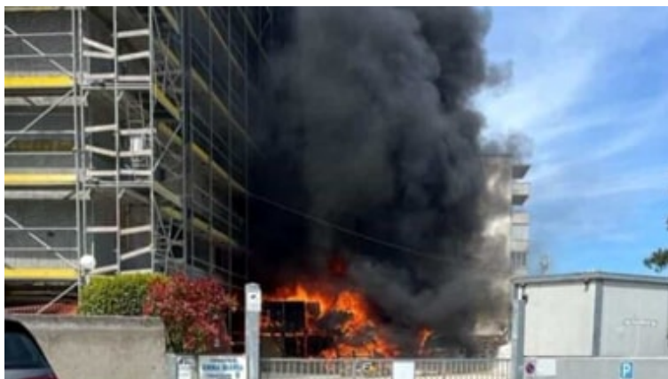
Figura 39. Incendio del materiale stoccato, foto di Massimo Argnani [41]
