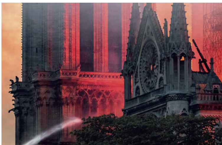
Figura 29. Incendio Notre Dame [5]
