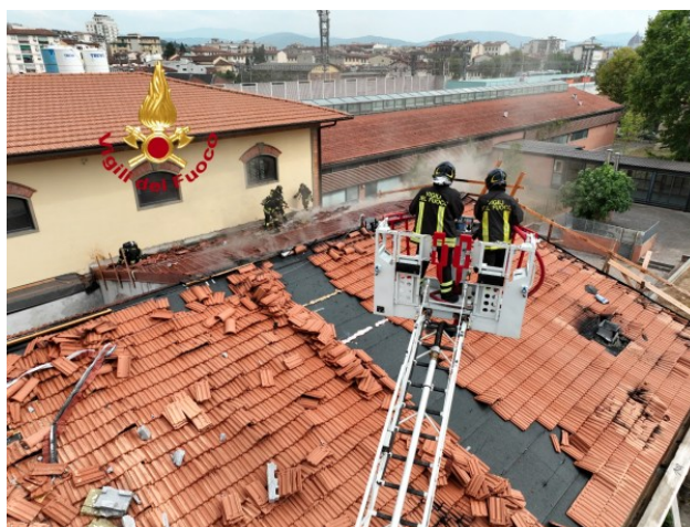
Figura 57. Copertura interessata dall'incendio [78]
