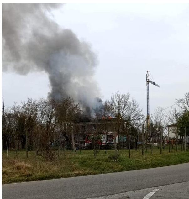
Figura 36. Incendio in copertura [36]
