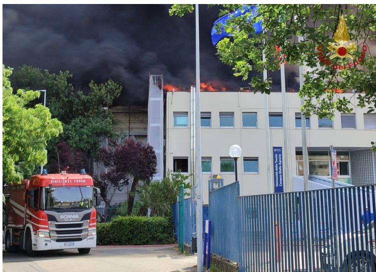
Figura 63. Incendio copertura Unitus [82]
