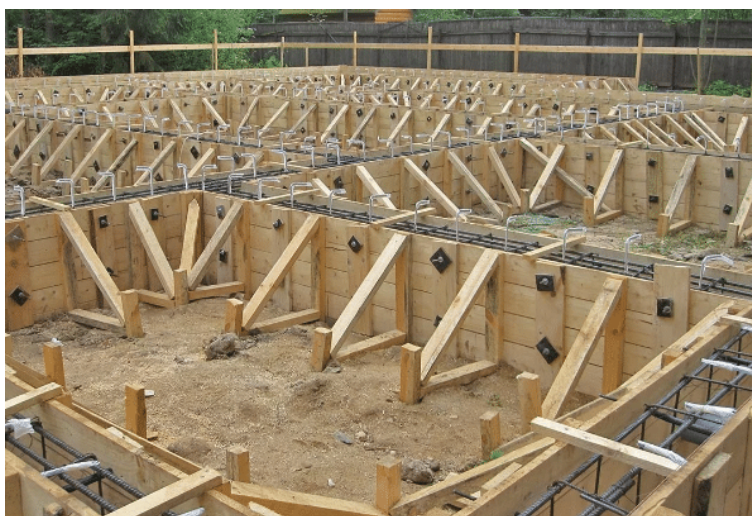
Figura 108. Casseforme in legno per calcestruzzo [108]
