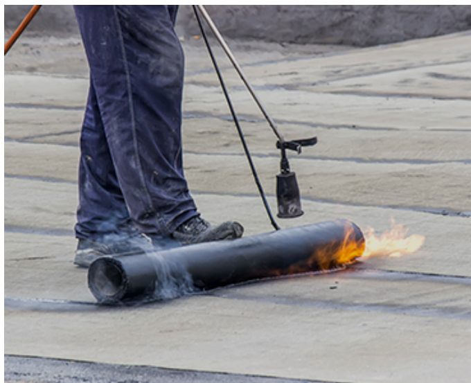
Figura 77. Posa membrana impermeabilizzante [90]
