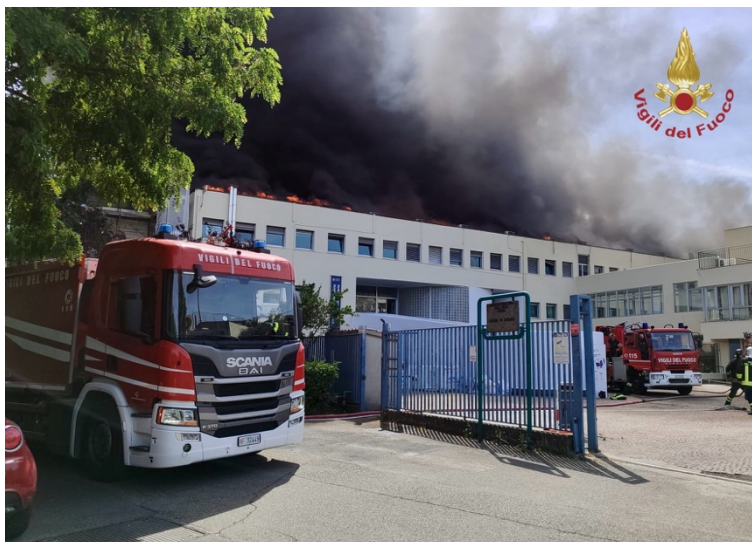
Figura 62. Incendio copertura Unitus [82]
