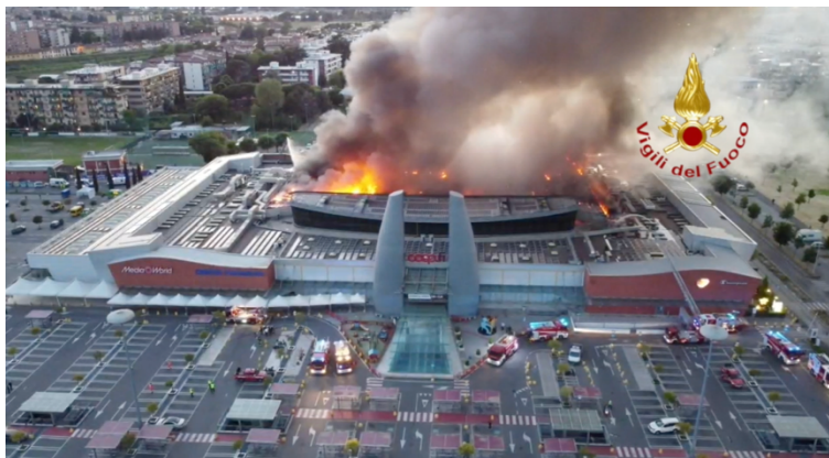
Figura 32. Incendio in copertura Unicoop [28]
