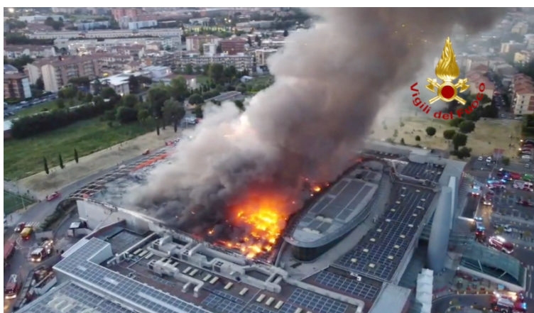
Figura 33. Incendio in copertura Unicoop [28]
