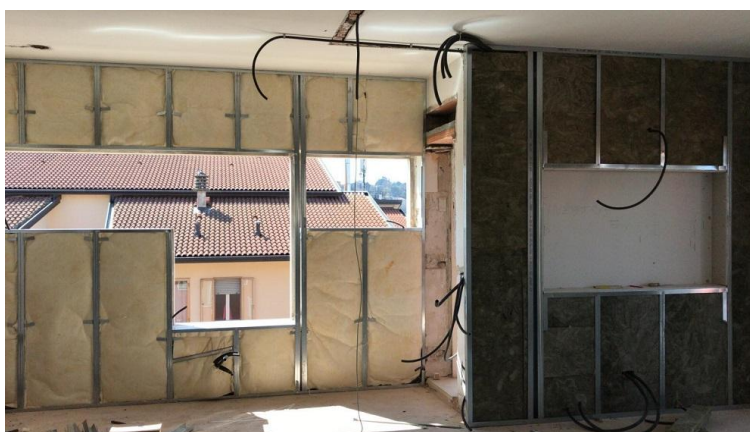
Figura 117. Realizzazione parete in cartongesso [111]
