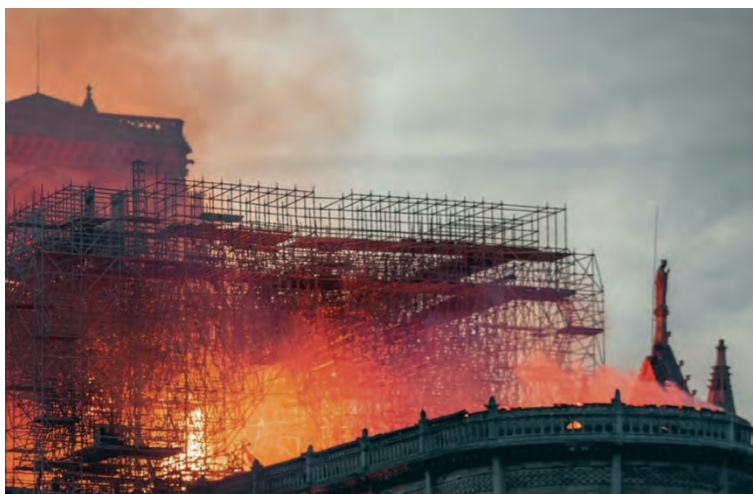
Figura 26. Incendio in corrispondenza del ponteggio [5]
