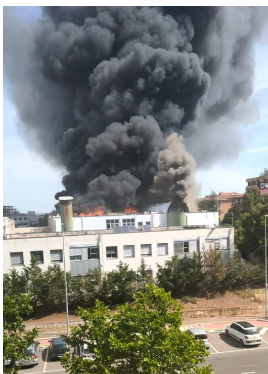
Figura 61. Incendio copertura Unitus [81]
