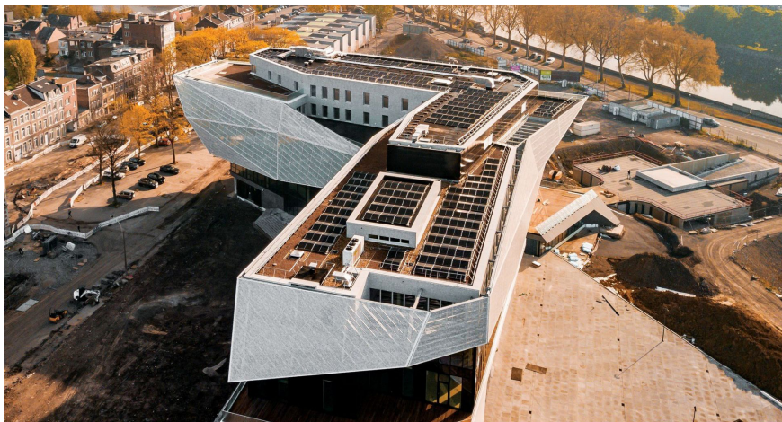
Figura 12 | Vista dall'alto dell'edificio B3 di Liegi (Belgio).
