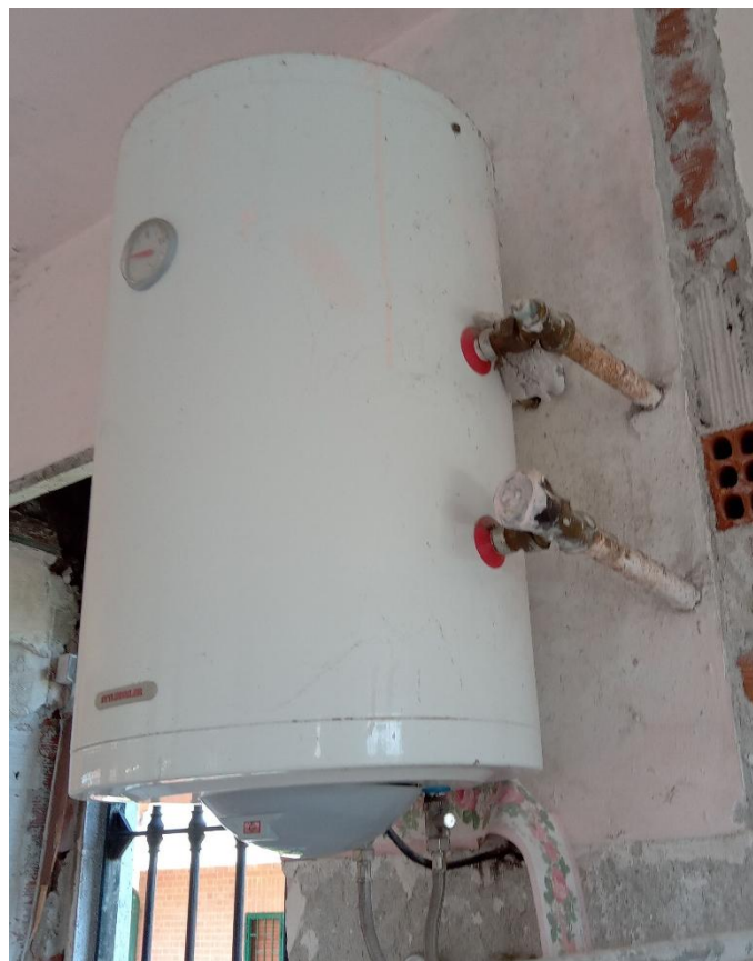
Figura 2.5 Bollitore elettrico
