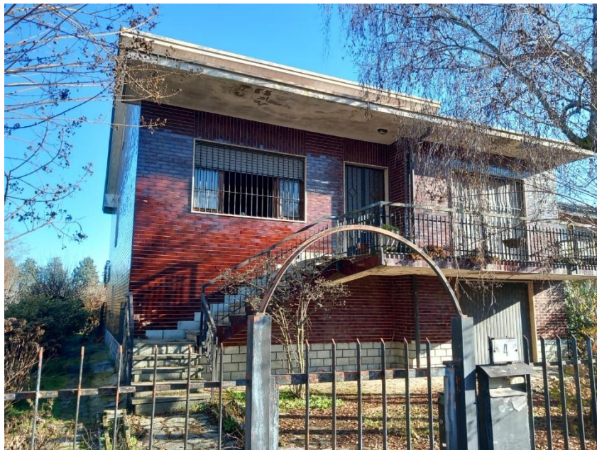
Figura 2.1 Edificio oggetto d'intervento
