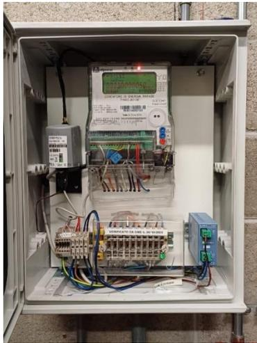
Figura 4-10: Esempio di contatore fiscale
