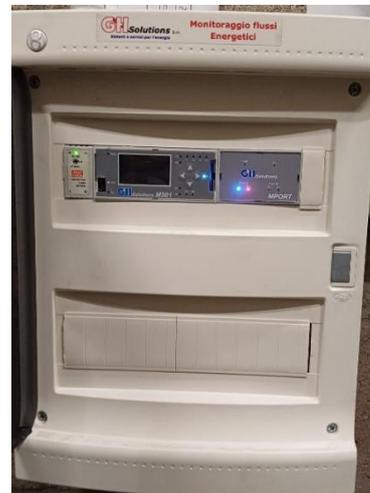
Figura 4-11: Unità di controllo GH Solutions
