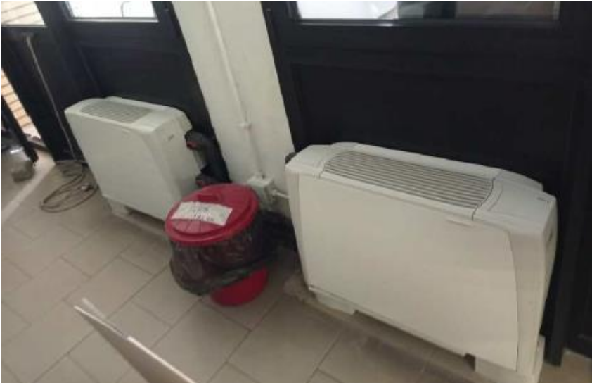
Figura 42 – Dettaglio ventilconvettore [5]
