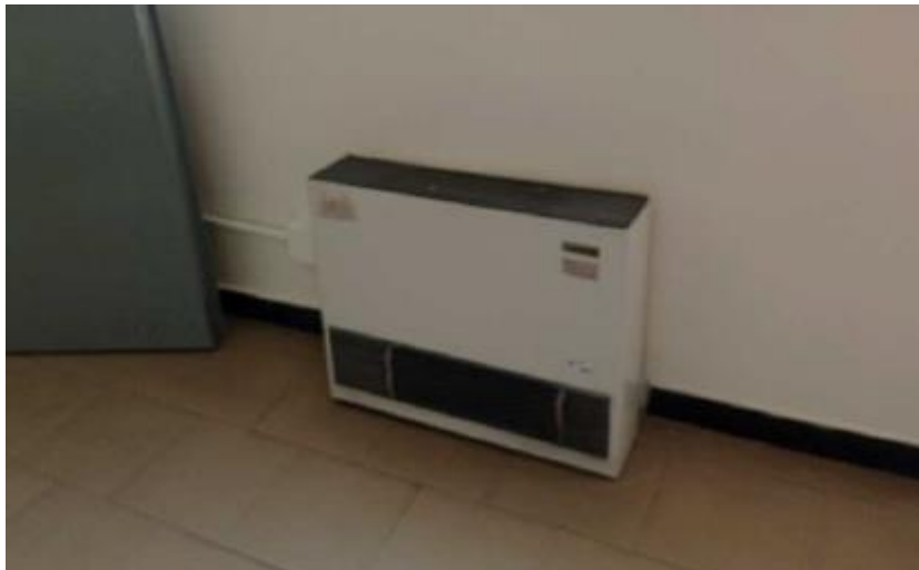
Figura 40 – Dettaglio ventilconvettore [5]
