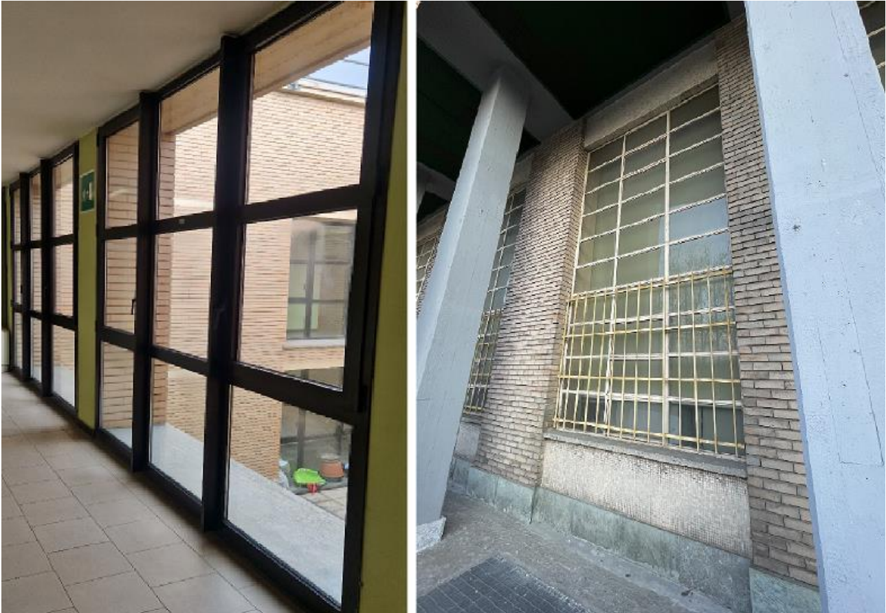
Figura 36 – Dettaglio di componenti trasparenti presenti nell'edificio 4A [5]
