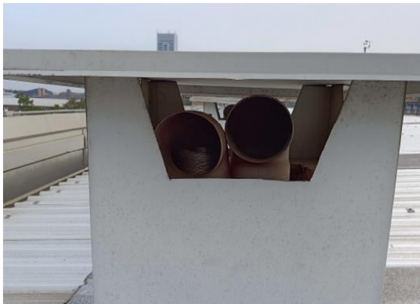
Figura 44 – Dettaglio della cappa di estrazione della ventilazione [5]
