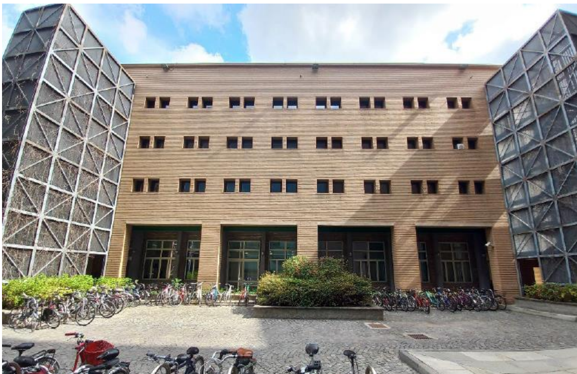
Figura 22 – Foto della parete ovest dell'edificio 4A su Corso Castelfidardo [5]
