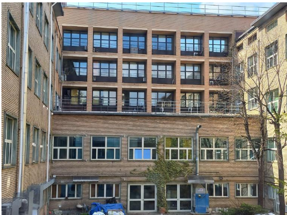
Figura 23 - Foto della parete est dell'edificio 4A su loggia interna [5]
