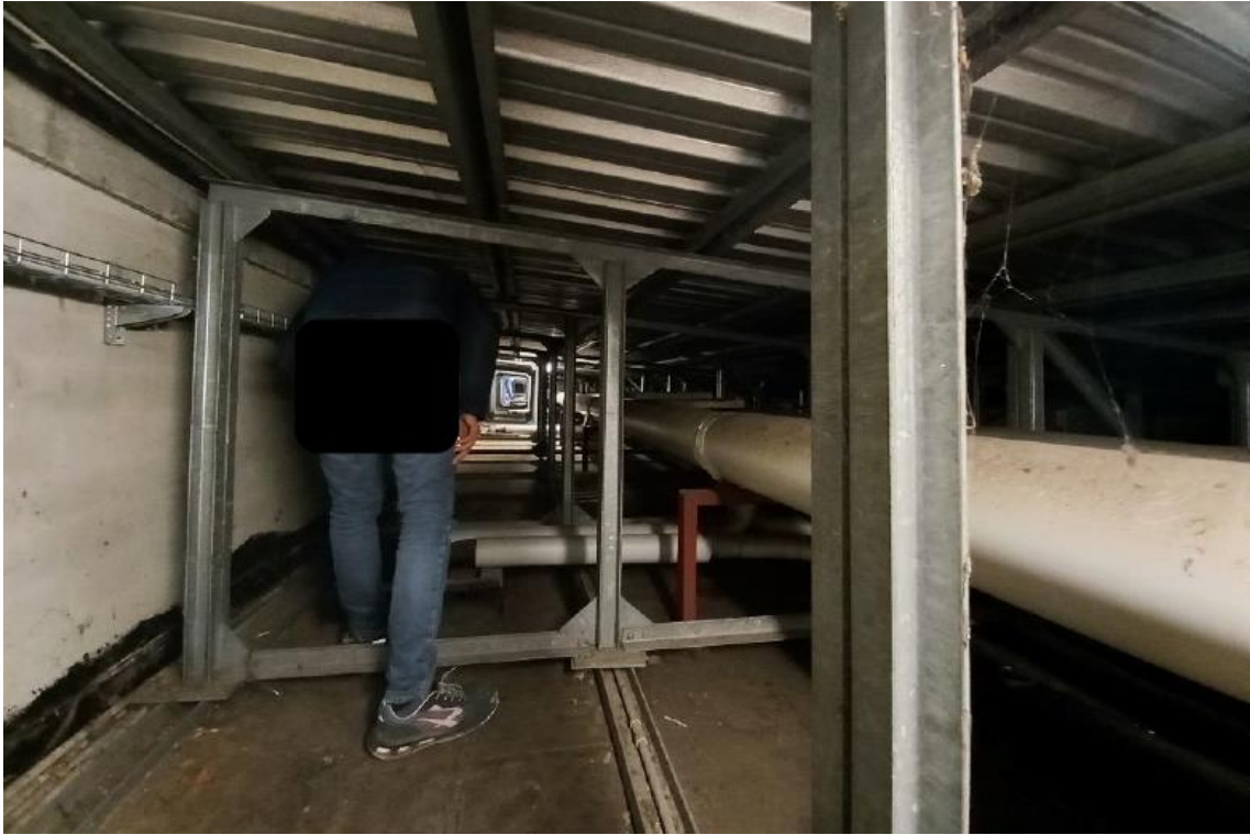
Figura 25 – Dettaglio del sottotetto dell'edificio 4A [5]
