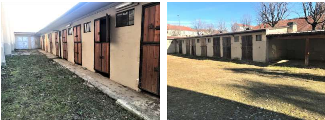
Figura 9 – Box cavalli esterni della Cavallerizza Caprilli [8]
