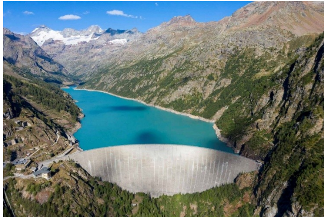
Figura 4: Diga di Place Moulin [5]
