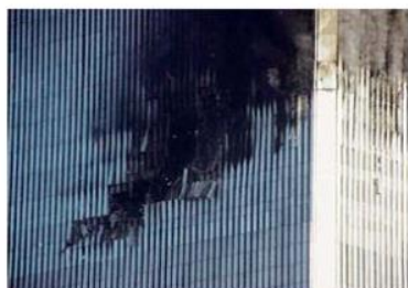
Figure 5: Zona d'impatto nella parete perimetrale Sud della Torre 2.
