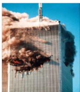
Figure 4: Zona d'impatto nella parete perimetrale Nord della Torre 1.
