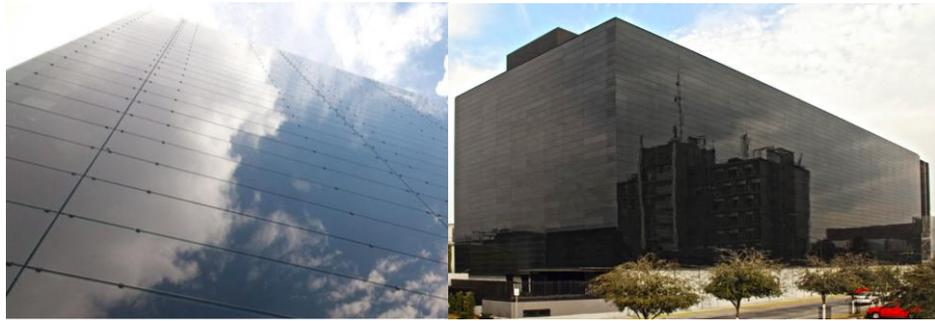
Figura 42 – Esempio di facciata fotovoltaica ventilata – Sede centrale della Coca Cola a Monterrey, Messico
