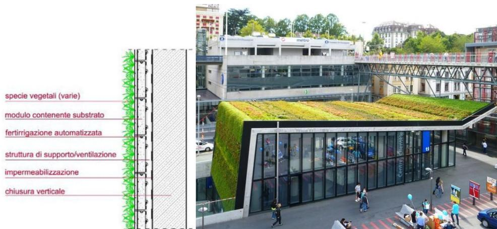
Figura 36 - Esempio di living wall – Stazione M2 di Losanna Flon
