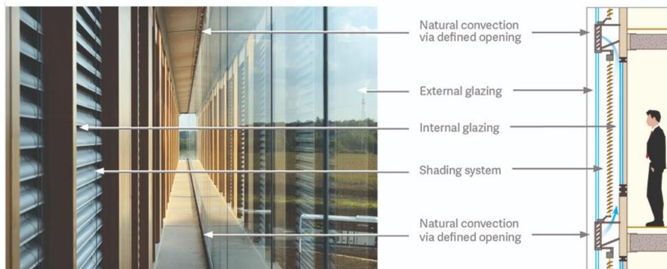
Figura 44 - Esempio di facciata a doppia pelle ispezionabile
