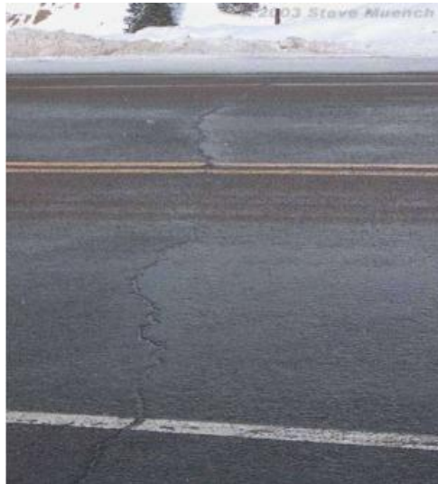
Figura 11 – Fessurazione trasversale
