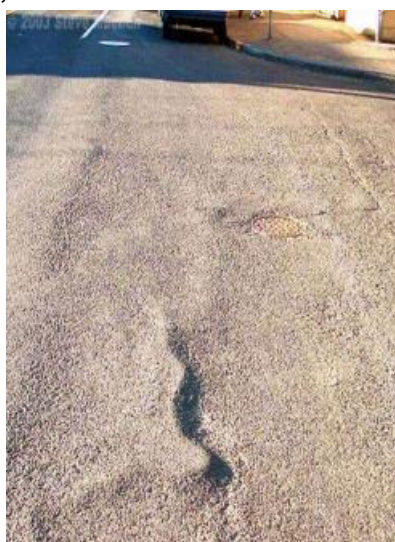
Figura 23 – Spostamento del manto per spinta orizzontale
