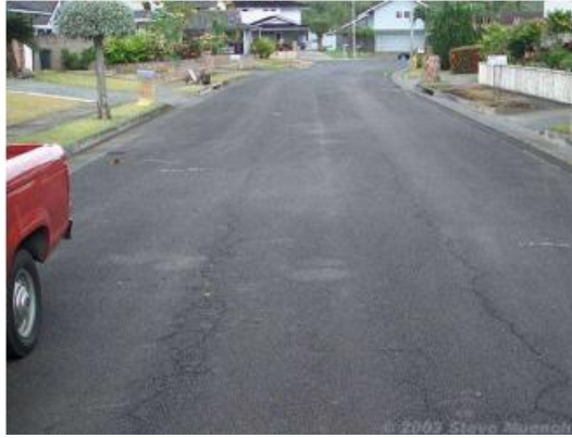
Figura 10 – Fessurazione longitudinale
