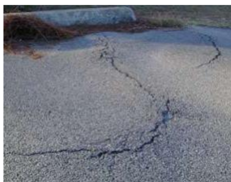
Figura 20 - Rigonfiamento
