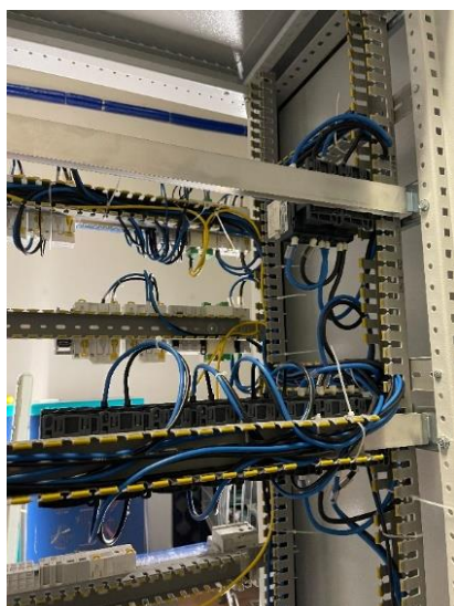
Figura 5-37: Foto del passaggio dei cavi in canalina e a passaggio sospeso
