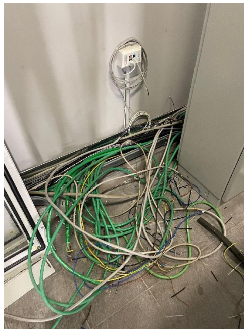
Figura 5-31: Cablaggi rimanenti dopo lo smantellamento del quadro in fase 1
