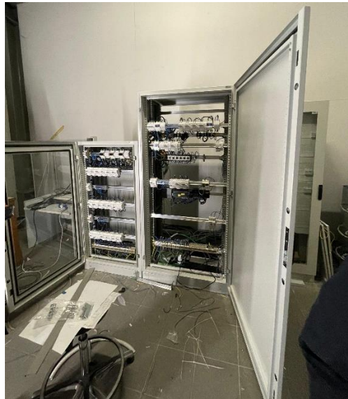
Figura 5-32: Nuova disposizione dei quadri
