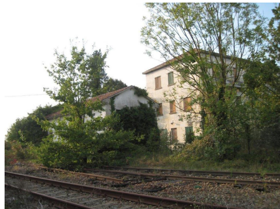
Figura 63 - Fotografia che rappresenta uno dei vari edifici che un tempo facevano parte del deposito di carburanti militari della zona
