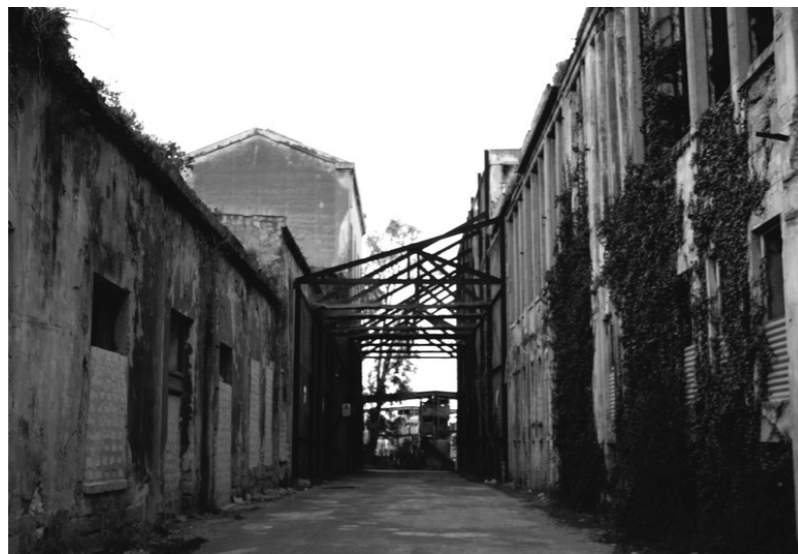
Figura 55, 56. Fabbricato centrale elettrica e officina meccanica, ex Chimica Arenella. Foto personali.
